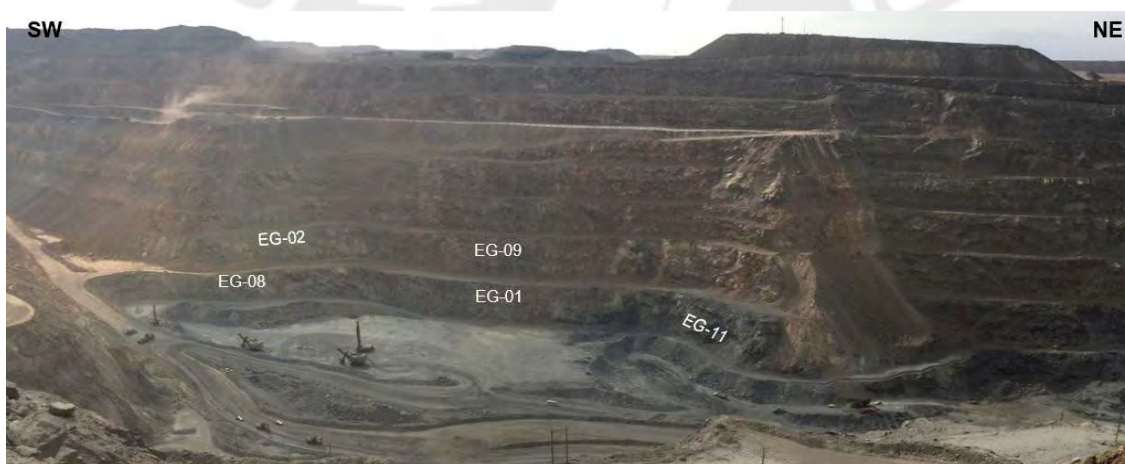
Figura 1-5: Ejemplo de evaluación geomecánica del macizo rocoso por medio de estaciones geomecánicas en los bancos de un tajo abierto
