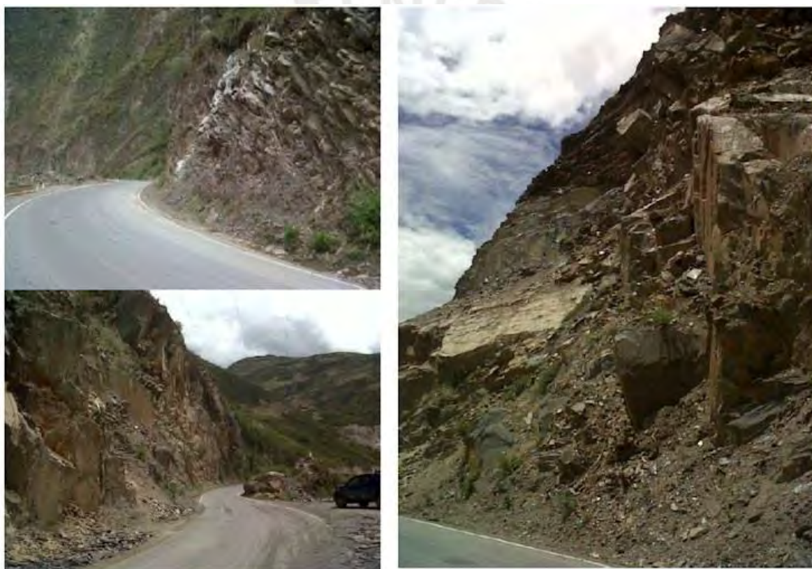
Figura 5-12: Vista del macizo rocoso 2 (Jordá y Tomás, 2014)
