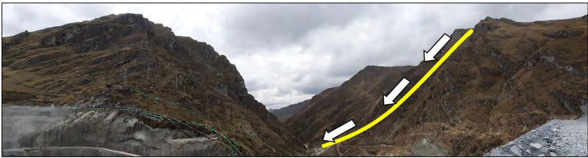
Figura 7-10: Vista del talud de la sección 1-1
