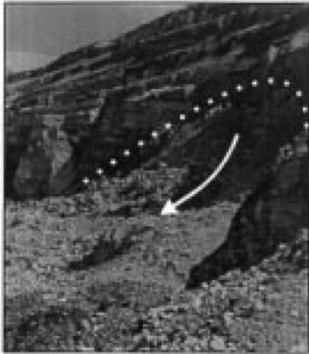
Figura 7-4: Rotura del talud en el tajo abierto Kiskadere (Sonmez y Ulusay, 1999)
