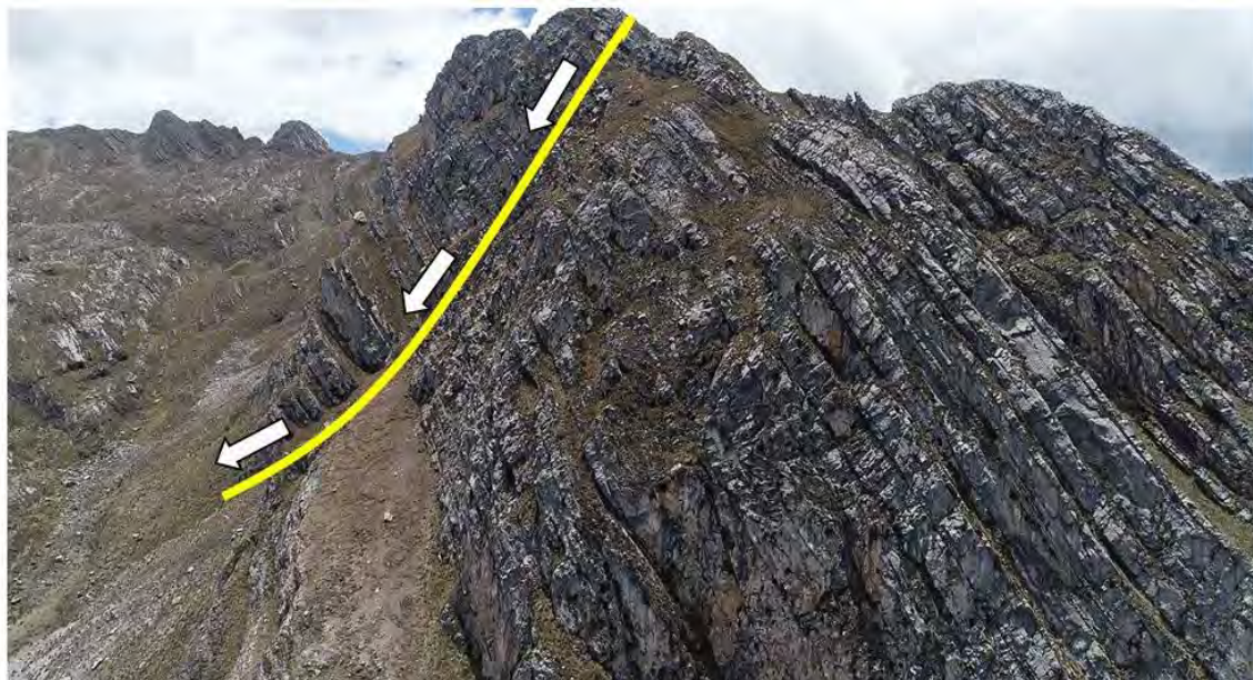
Figura 7-11: Vista del talud de las secciones 2-2 y 3-3
