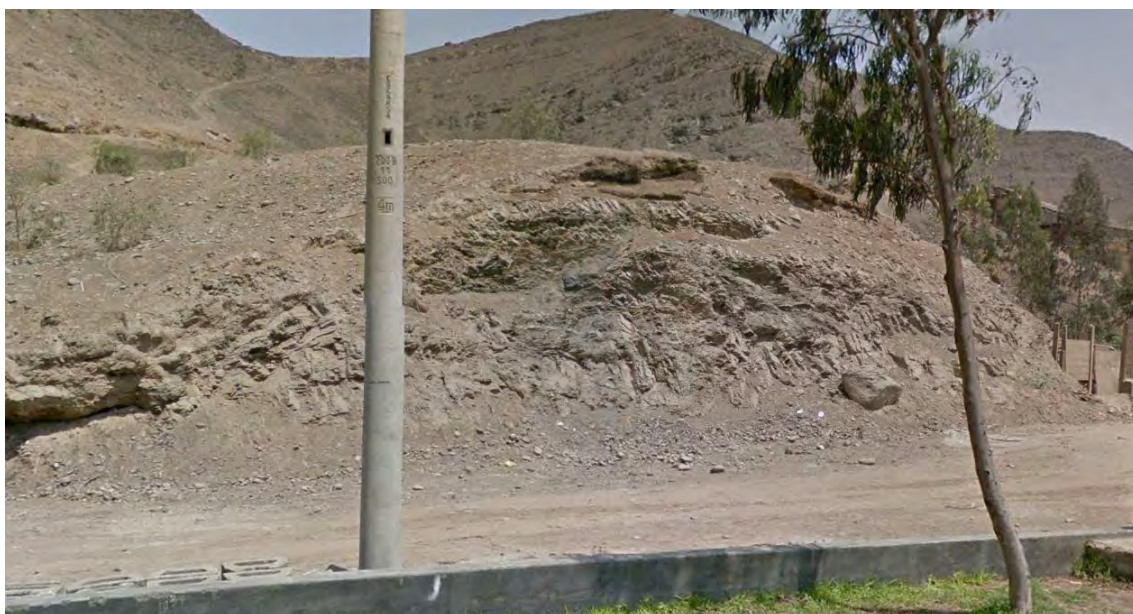
Figura 5-13: Vista del macizo rocoso 3
