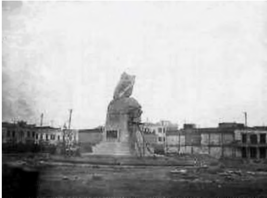
Ilustración 71. Plaza San Martín en construcción. 1921. Recuperado de: Google Imágenes.
