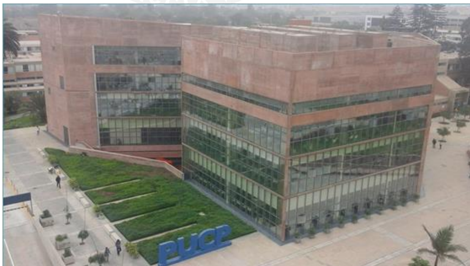
Figura 3-2: Vista de frente del CIA
