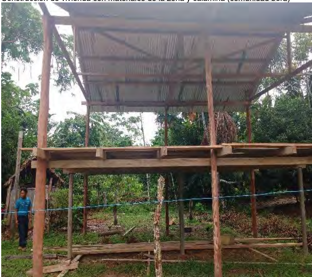
Figura 20 Construcción de vivienda con materiales de la zona y calamina (comunidad bora)
