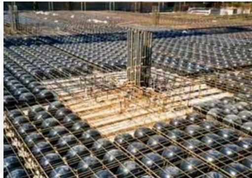
Figura 13: Retiro de esferas en toda la zona crítica de punzonamiento.
