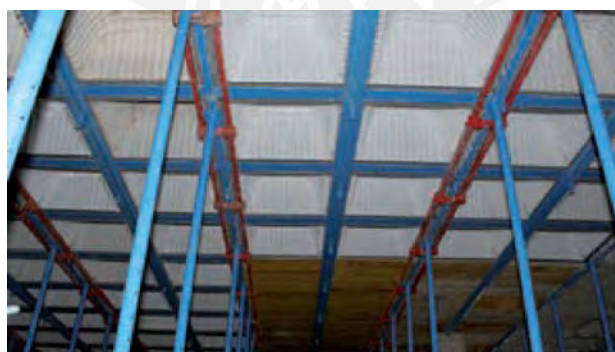
Figura 5: Encofrado de losa nervada con casetón recuperable NORPIN.
