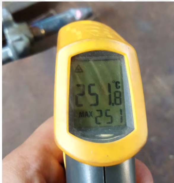
Figura 56. Medición de temperatura entre pasadas mediante pirómetro.
