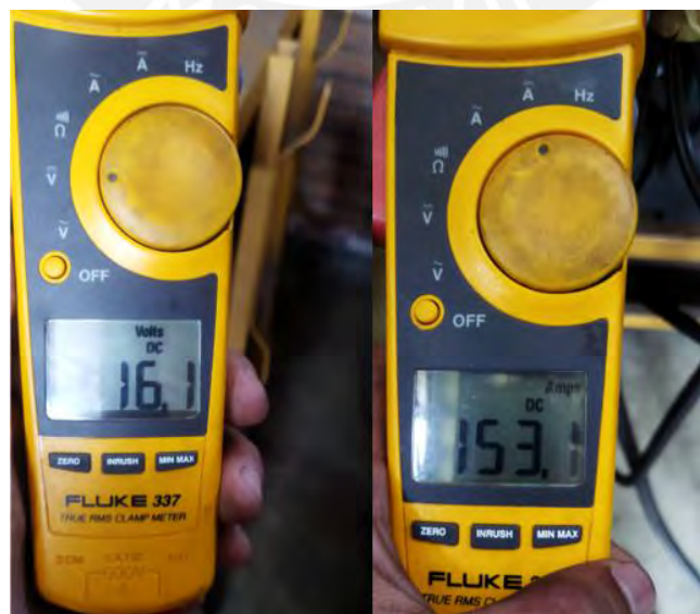
Figura 54. Medición de voltaje y amperaje en el equipo de soldadura.
