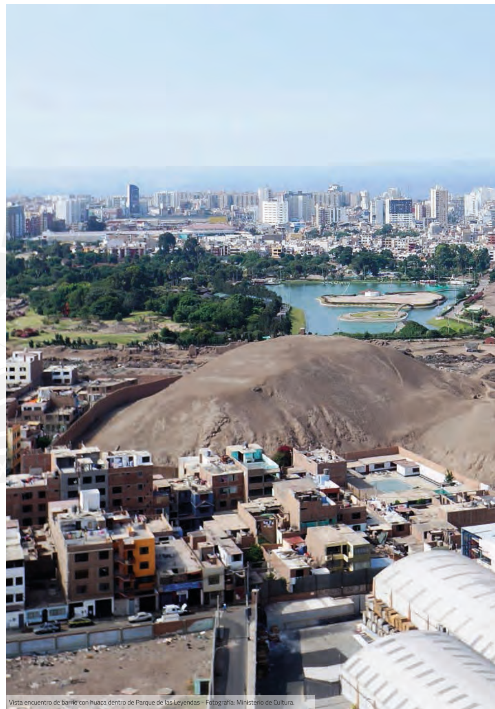
Vista encuentro de barrio con huaca dentro de Parque de las Leyendas - Fotografía: Ministerio de Cultura.
