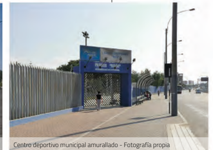
Centro deportivo municipal amurallado - Fotografía propia
