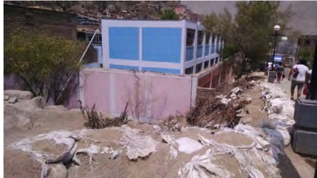
Fuente: Flor Villa Q. Año 2015. Colegio afectado por lodo.
