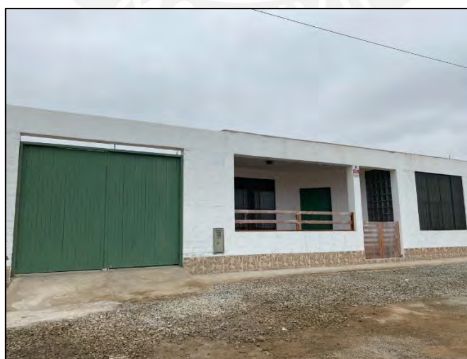
Figura 18: Vivienda de 1 piso usada para aplicación y adaptación del método
