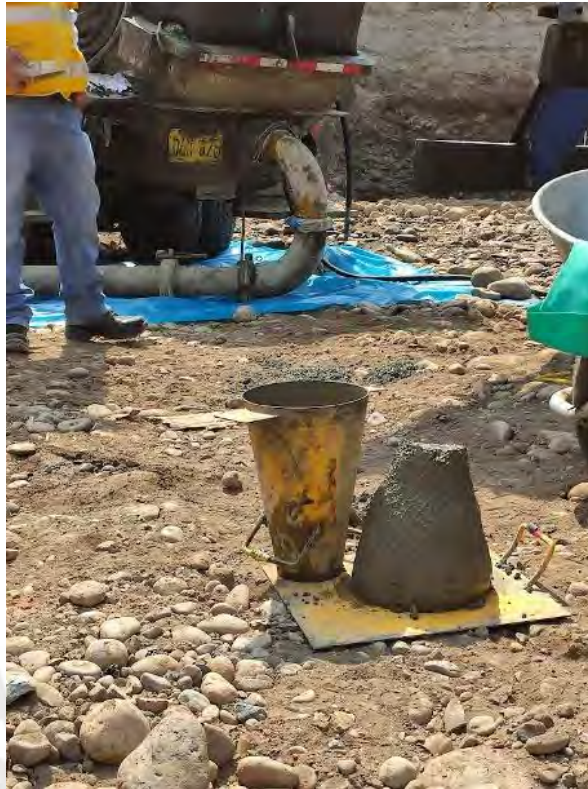
Figura 16. Verificación de slump de concreto.
