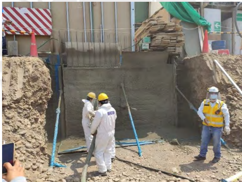
Figura 18. Aplicación final de concreto lanzado.
