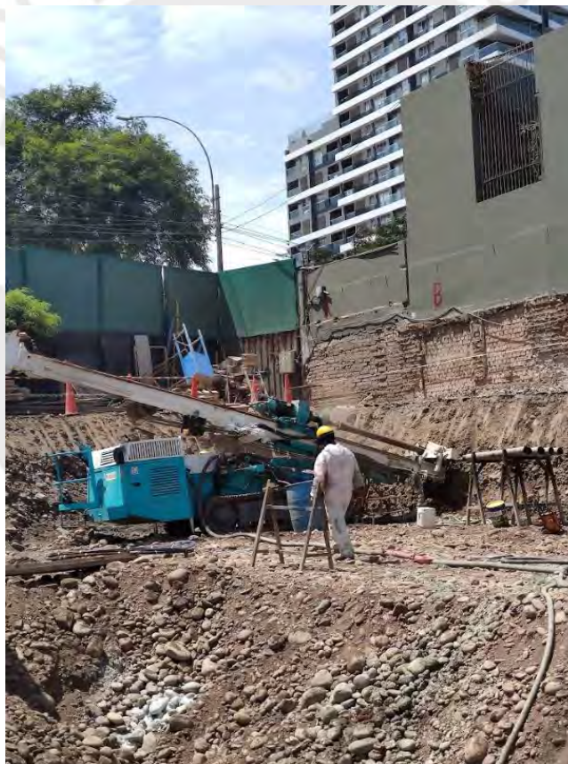
Figura 8. Perforación e introducción de cable con hydraulic drill rig. Nota. Tomado de Inmobiliaria 1.
