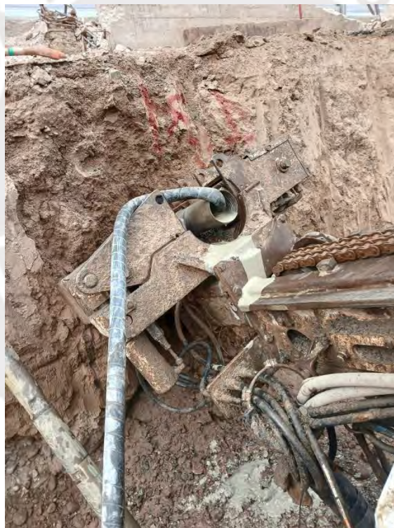
Figura 2. Relleno con lechada luego de perforación y colocación de cables de tensado. Nota. Tomado de Inmobiliaria 2.
