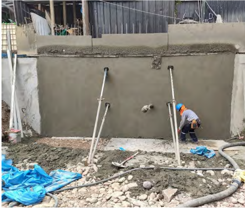
Figura 21. Acabado final de muro anclado.
