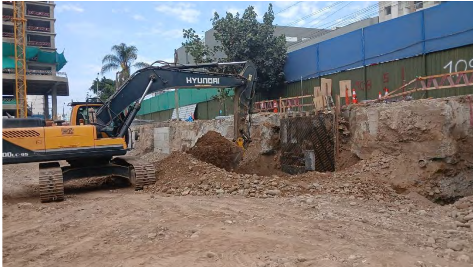
Figura 5. Excavadora colocando material enfrente del muro encofrado para sostenimiento del mismo. ( pachamanca )
