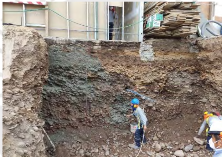
Figura 12. Aplicación de lechada de concreto sobre banqueta. Nota. Tomado de Inmobiliaria 1.
