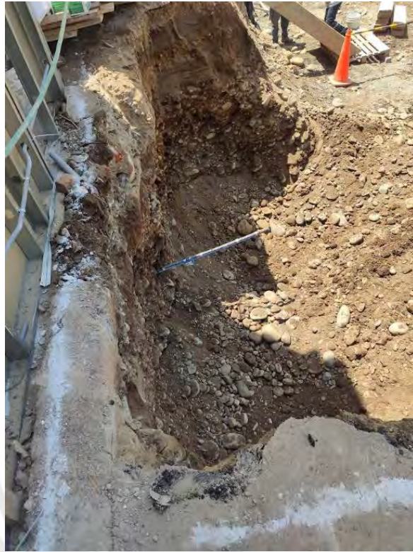
Figura 10. Zona liberada de muro anclado. Nota. Tomado de Inmobiliaria 1.
