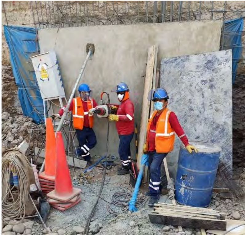
Figura 22. Tensando de cables.
