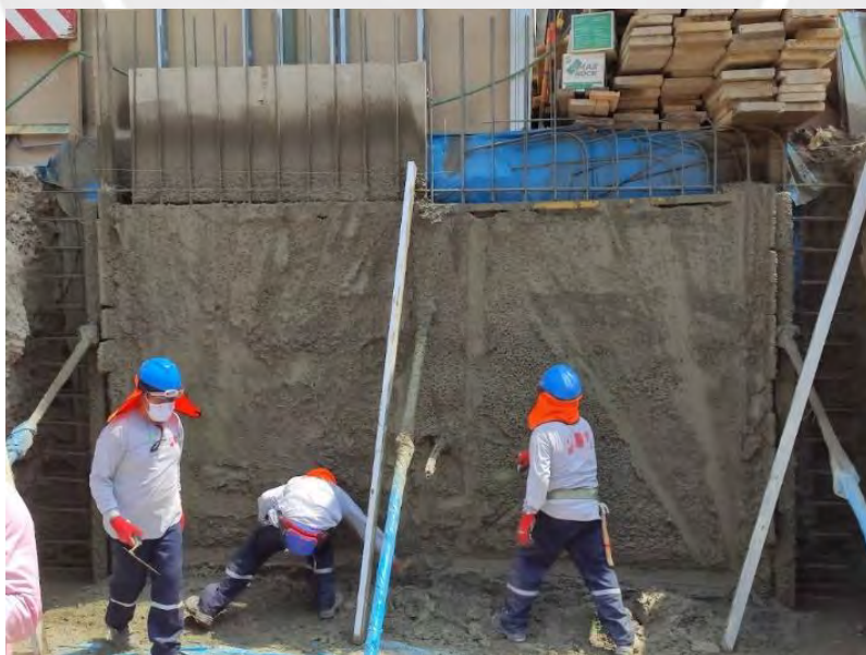
Figura 20. Alineamiento de muro anclado.
