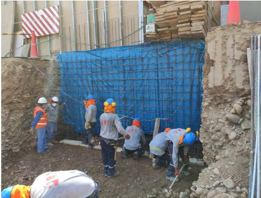
Figura 14. Colocación de mallas de acero de muro anclado. Nota. Tomado de Inmobiliaria 1
