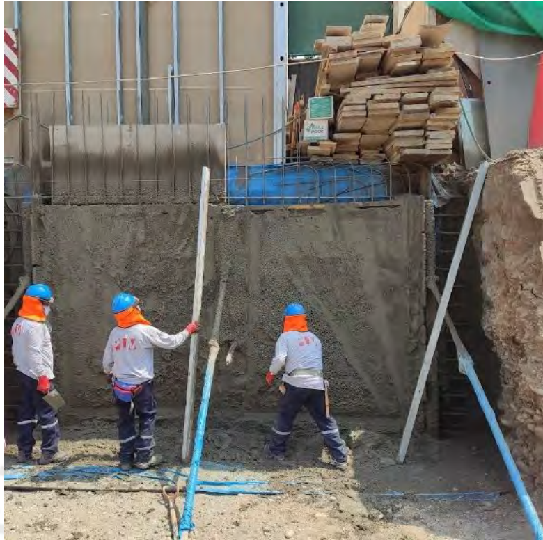
Figura 19. Alineamiento de muro anclado.
