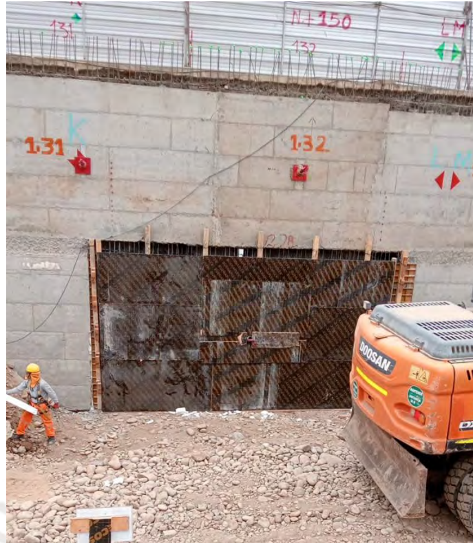
Figura 4. Paño de muro anclado encofrado con paneles de encofrado y fenólicos. Nota. Tomado de Inmobiliaria 2.
