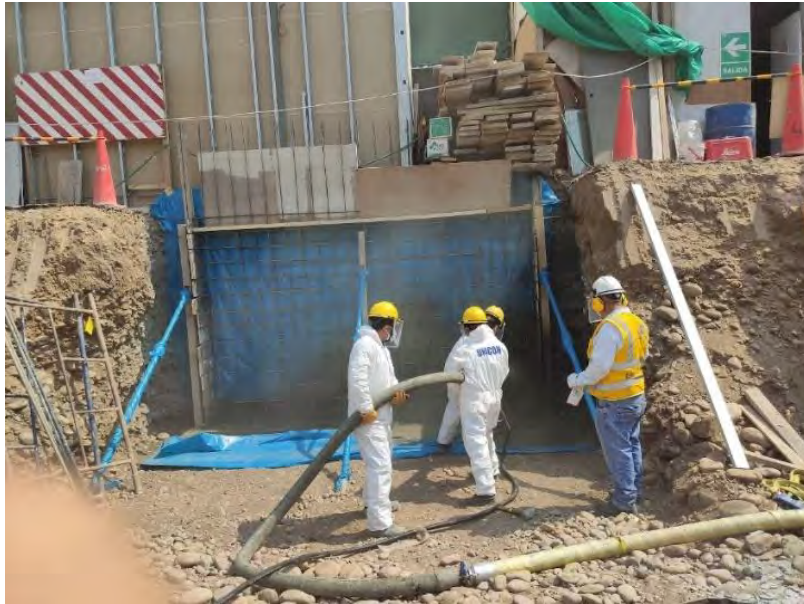
Figura 17. Aplicación de concreto lanzado por medio de compresora de aire.
