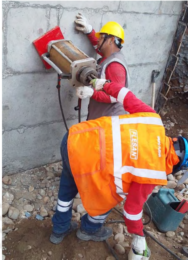
Figura 6. Tensado de anclaje de muro anclado por parte de contratista. Nota. Tomado de Inmobiliaria 2.
