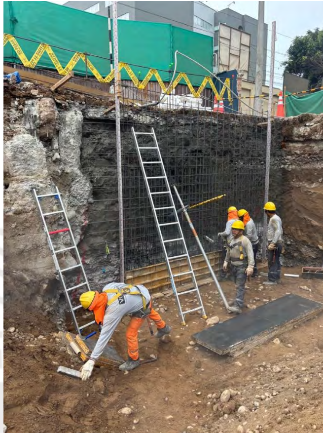
Figura 3. Paño de muro anclado con mallas de acero colocado según planos de diseño. Nota. Tomado de Inmobiliaria 2.
