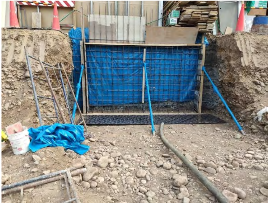
Figura 15. Encofrado final de muro anclado. Nota. Tomado de Inmobiliaria 1.
