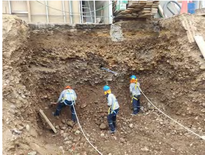
Figura 11. Perfilado manual de banqueta. Nota. Tomado de Inmobiliaria 1.
