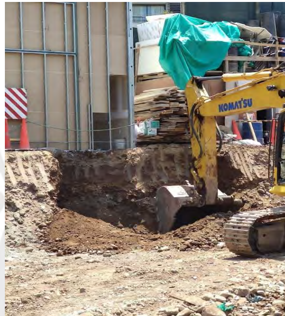
Figura 9. Excavación localizada de banqueta realizada por excavadora
