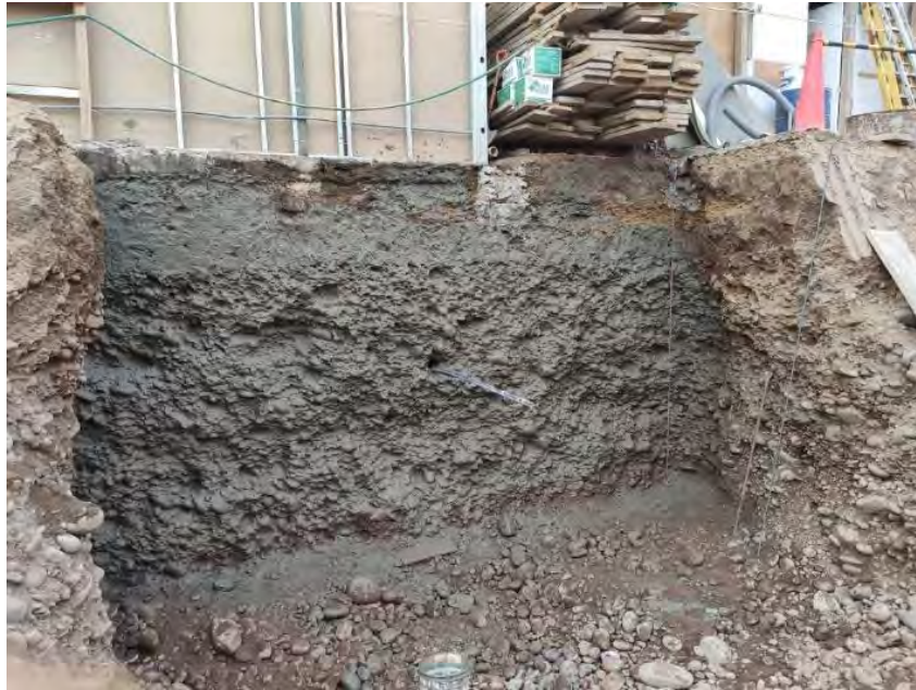
Figura 13. Resultado final de aplicación de lechada de concreto sobre banqueta. Nota. Tomado de Inmobiliaria 1.
