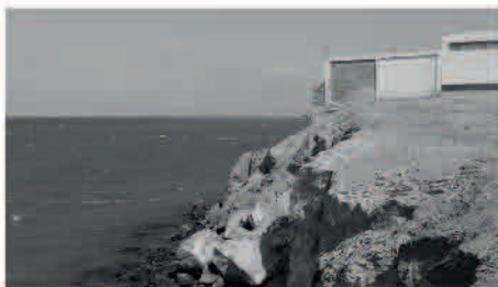
Arquitectura ajena al lugar
