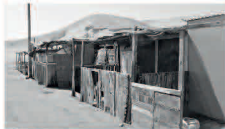
Arquitectura ajena al lugar
