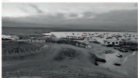
Arquitectura ajena al lugar
