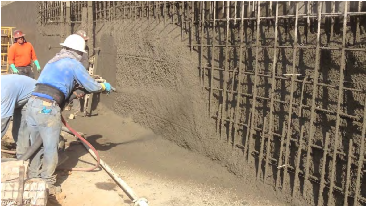
Figura 3: Aplicación del shotcrete en estabilización de taludes.
