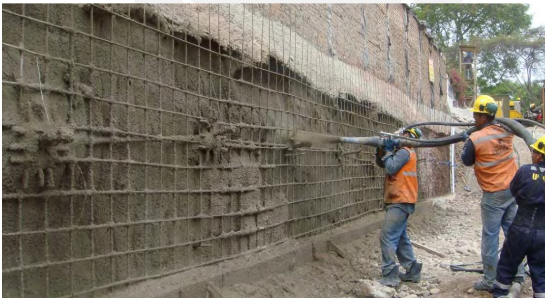
Figura 6: Aplicación del shotcrete por vía húmeda por UNICON
