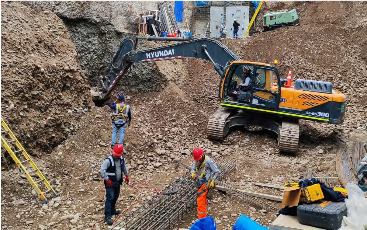
Figura 14. Excavación localizada del paño. Fuente: Propia.
