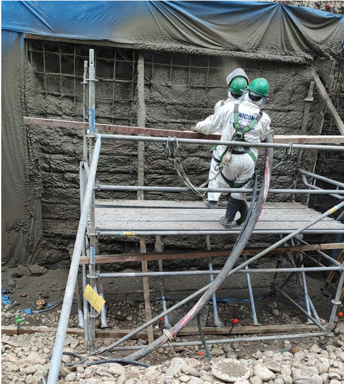
Figura 20. Proyección del concreto en el paño correspondiente. Fuente: Propia.
