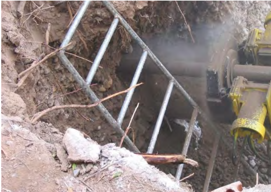
Figura 25. Perforación y preparación para el anclaje.
