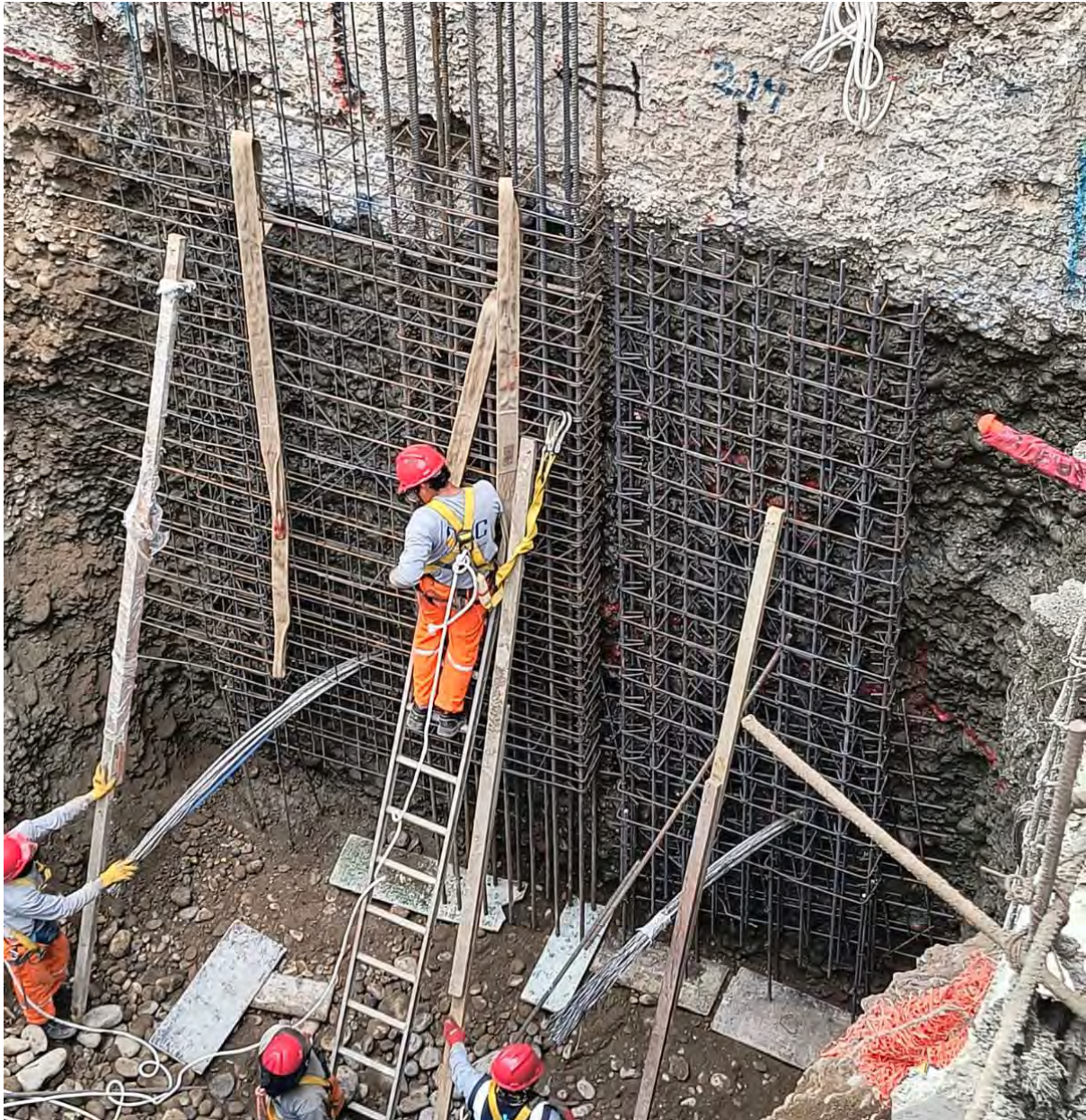
Figura 16. Habilitación de acero y apuntalamiento. Fuente: Propia.
