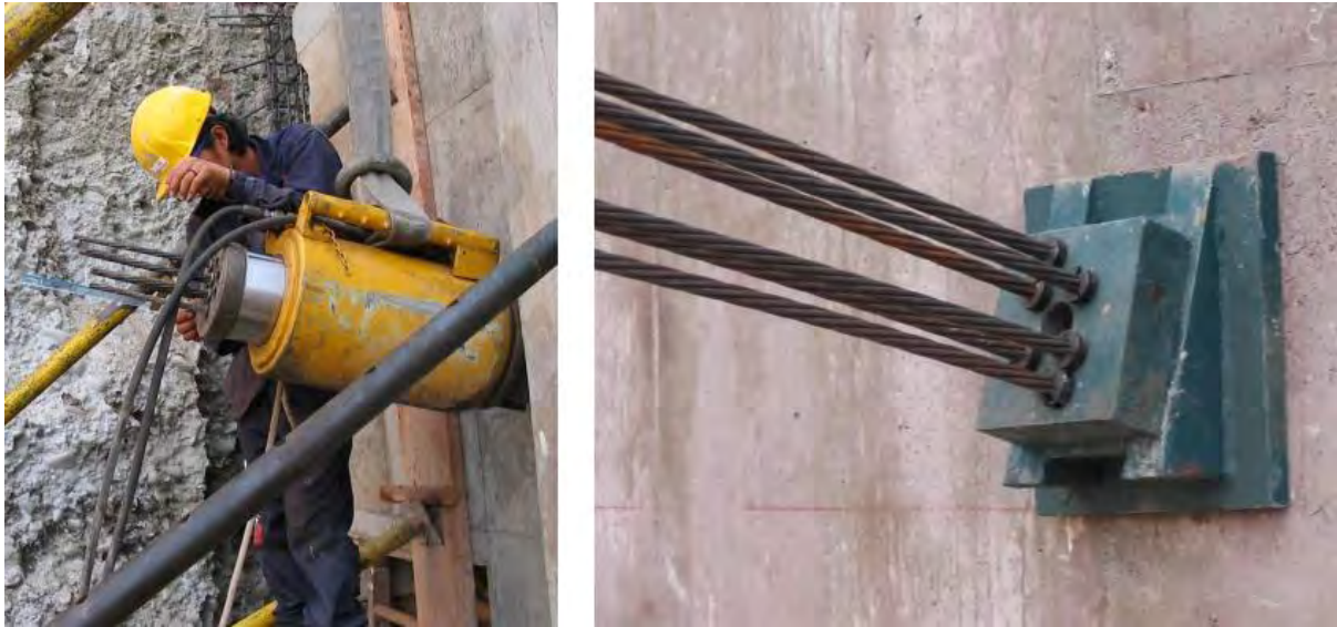
Figura 30. Desencofrado y tensado de cables.
