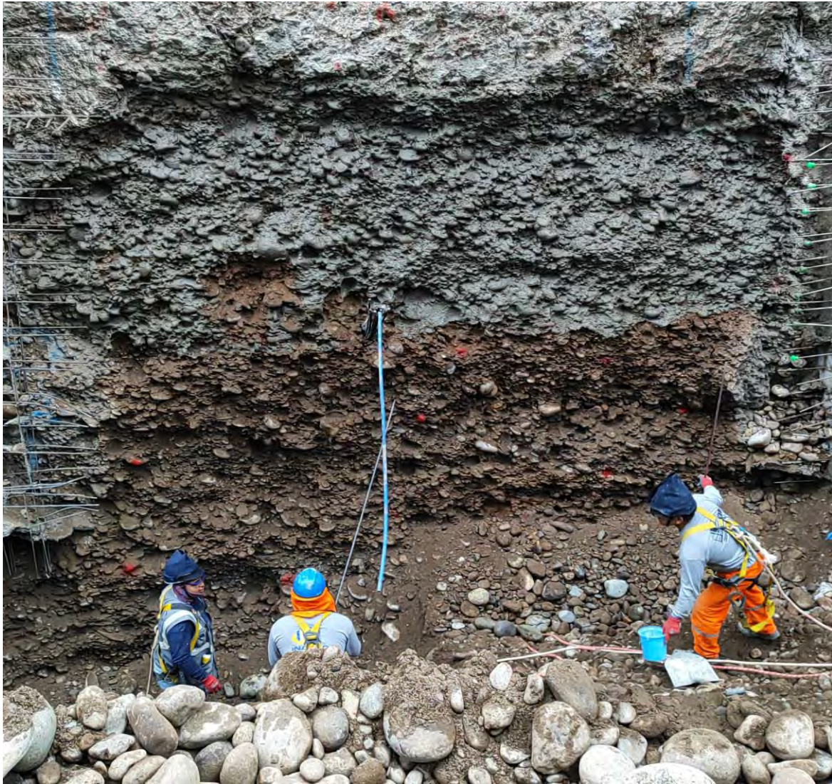
Figura 15. Perfilado y lanzado manual de lechada en muro. Fuente: Propia.
