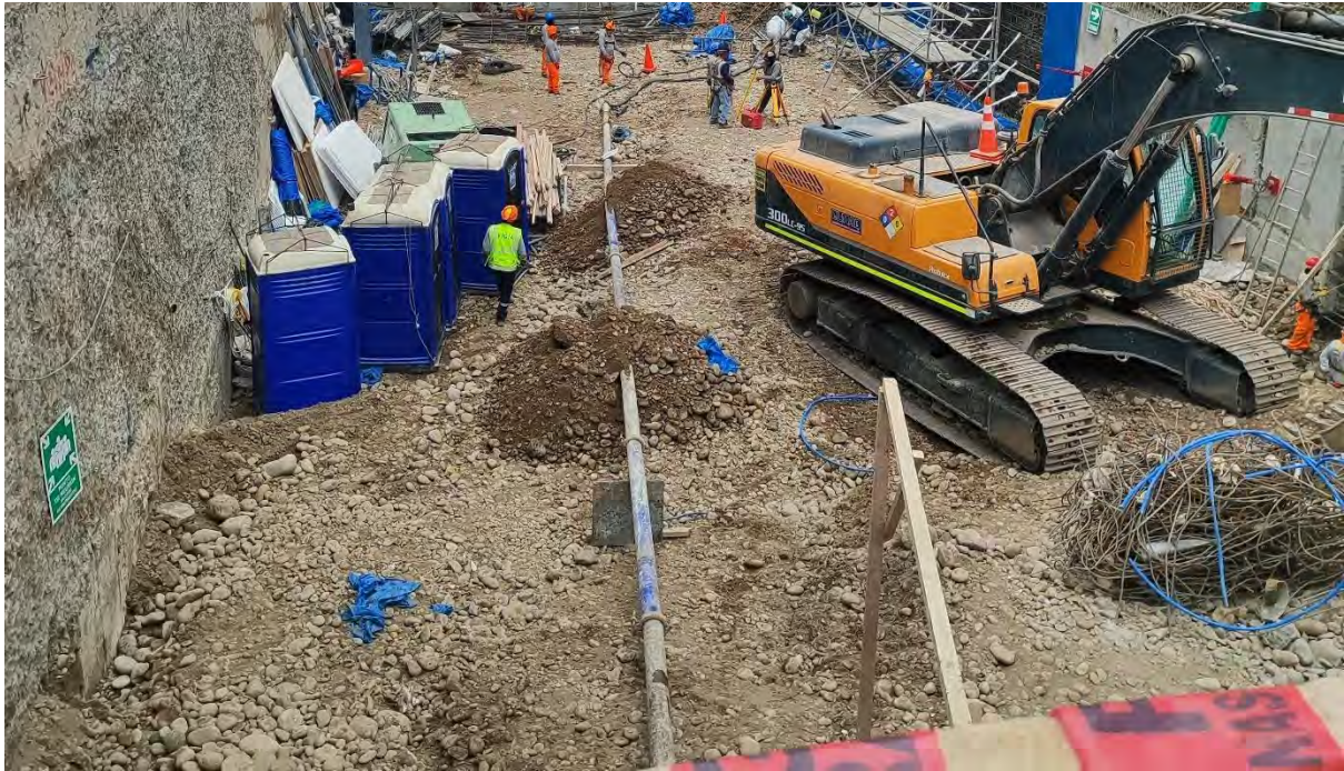
Figura 19. Instalación de la línea de bombeo
