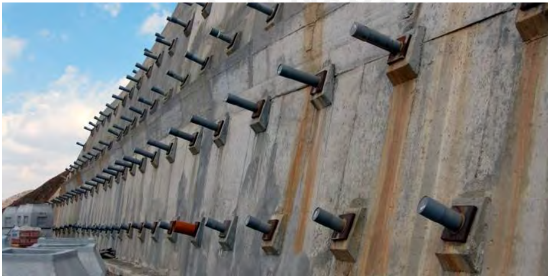
Figura 2: Estabilización de talud con muros anclados
