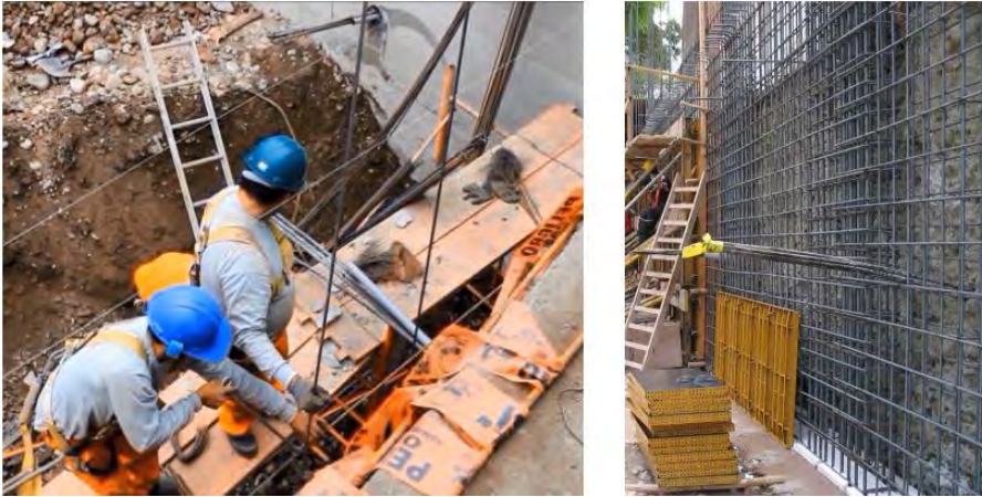
Figura 26. Colocación y habilitación del acero.
