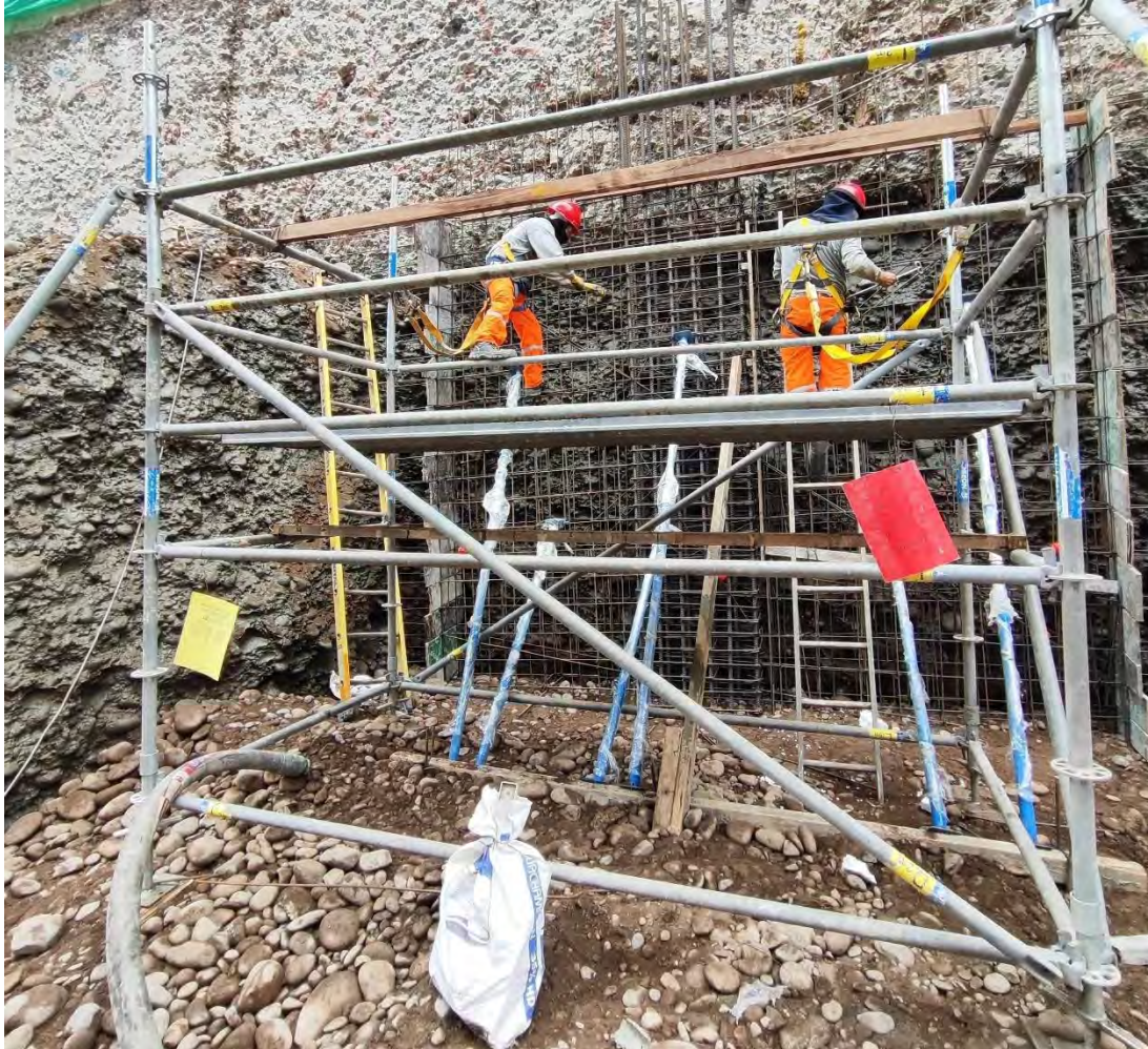
Figura 17. Instalación de andamios multidireccional Fuente: Propia.
