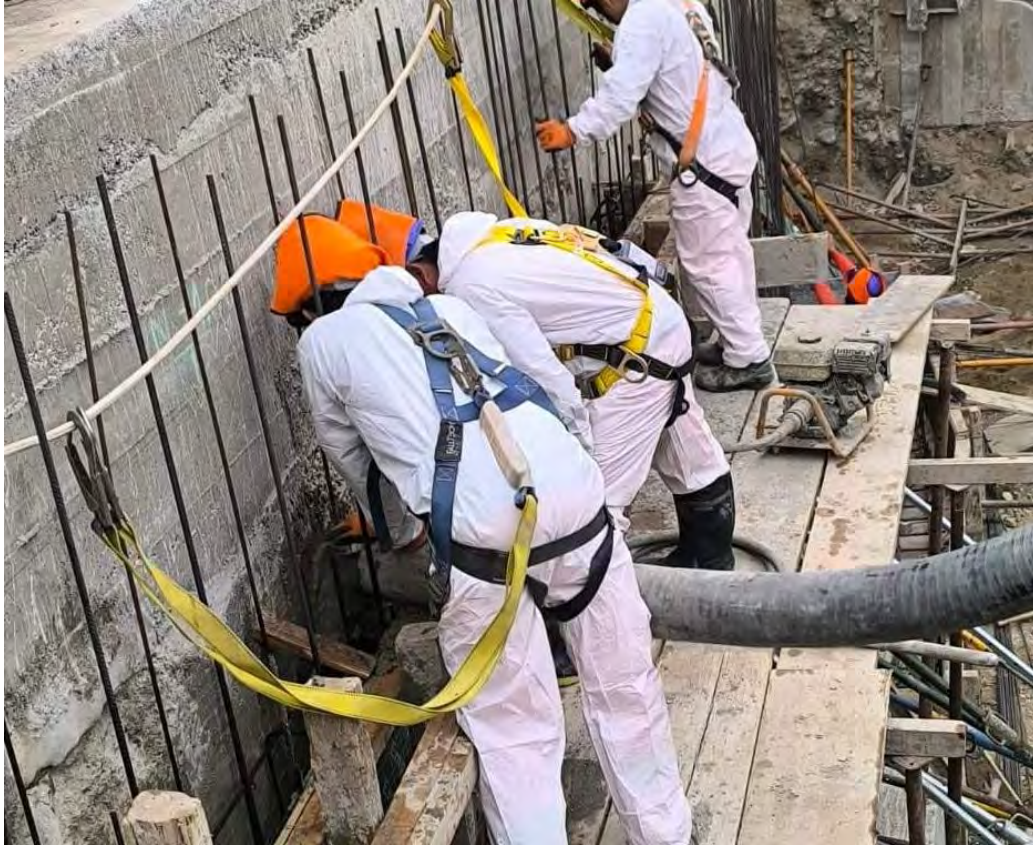
Figura 29. Vaciado del concreto en paño del muro anclado.
