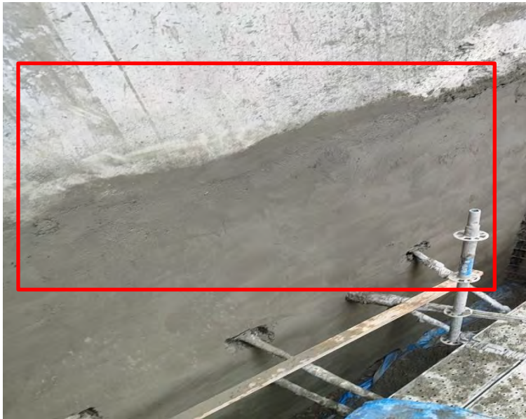
Figura 37. Detalle de unión entre paños con concreto lanzado.
