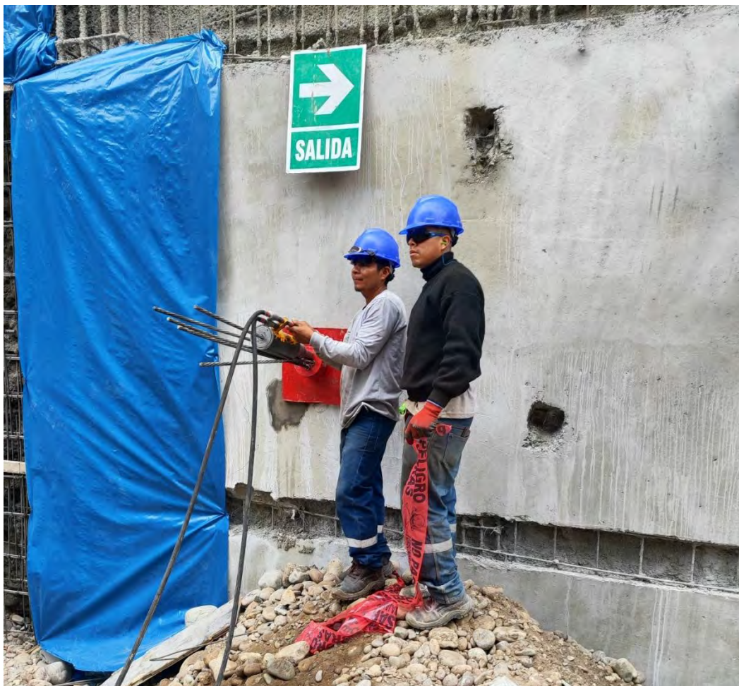
Figura 22. Tensado de cables del paño terminado. Fuente: Propia.
