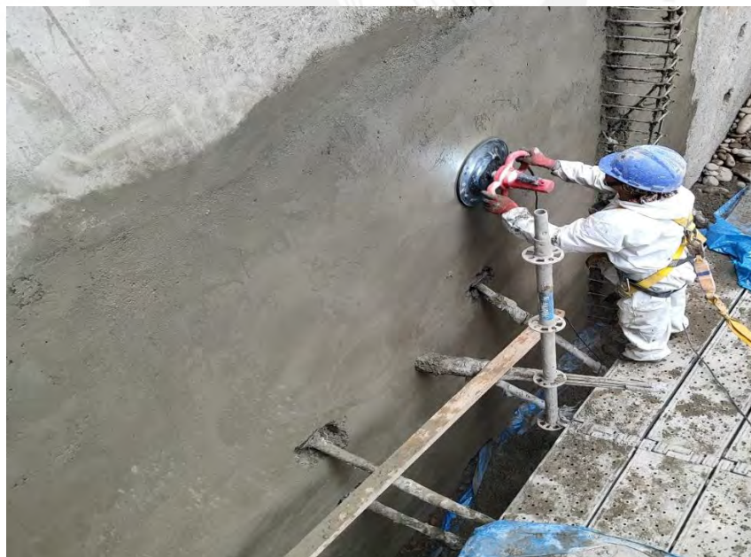
Figura 36. Acabo en estado fresco del concreto lanzado. Proyecto Milano.
