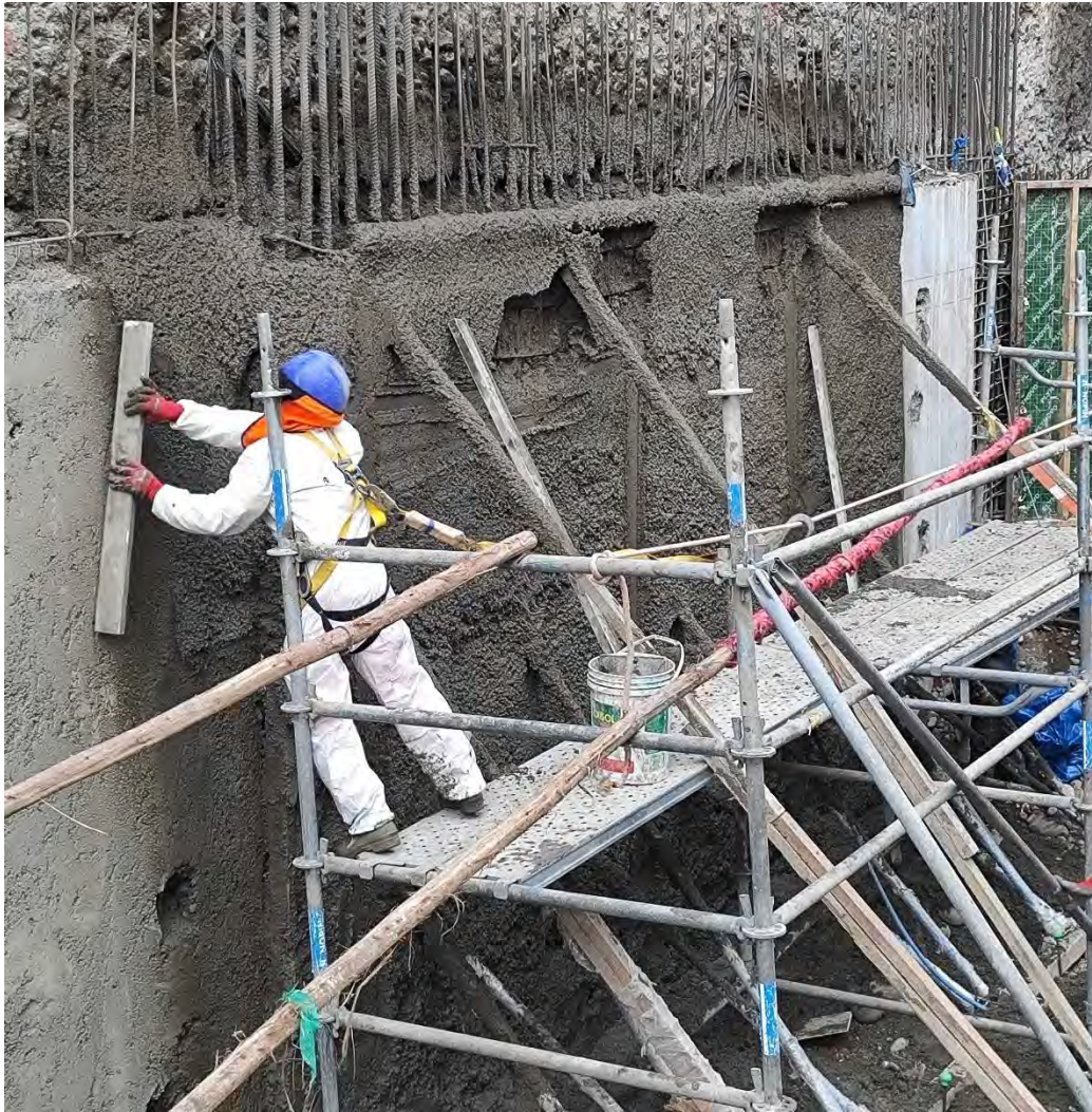
Figura 21. Enlucido del paño lanzado. Fuente: Propia.
