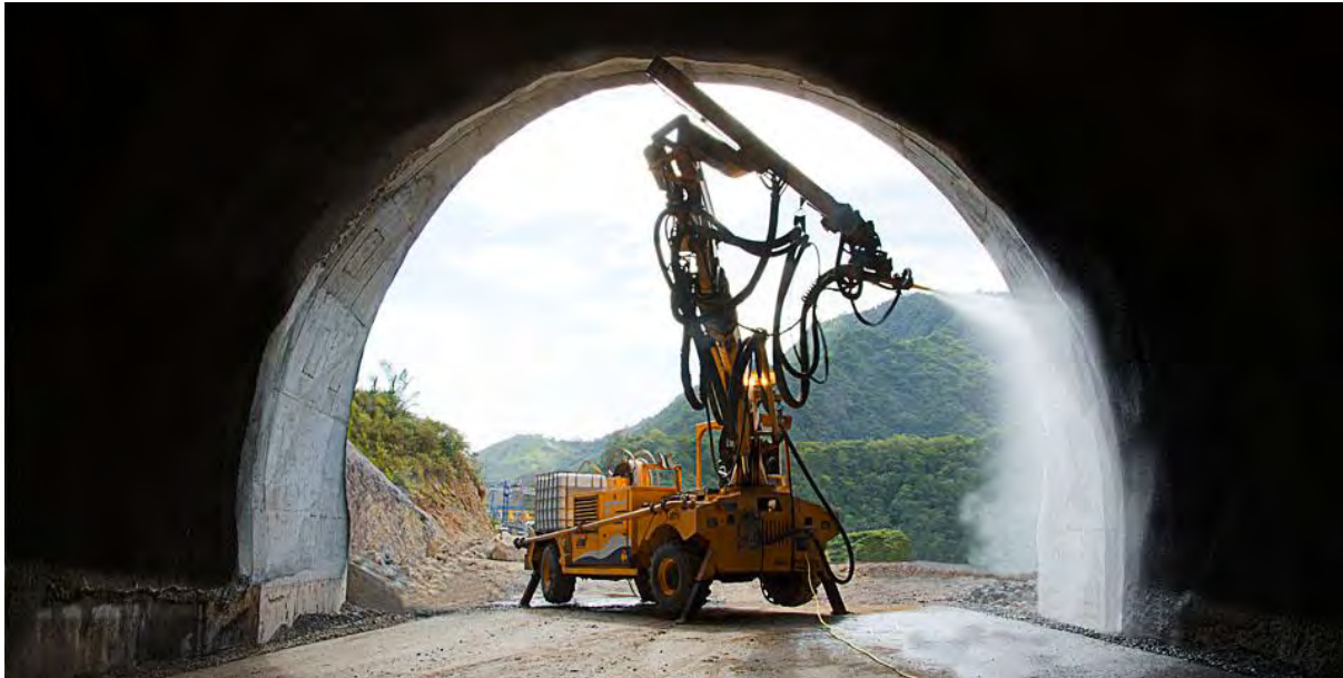
Figura 4: Inyección de concreto por vía seca
