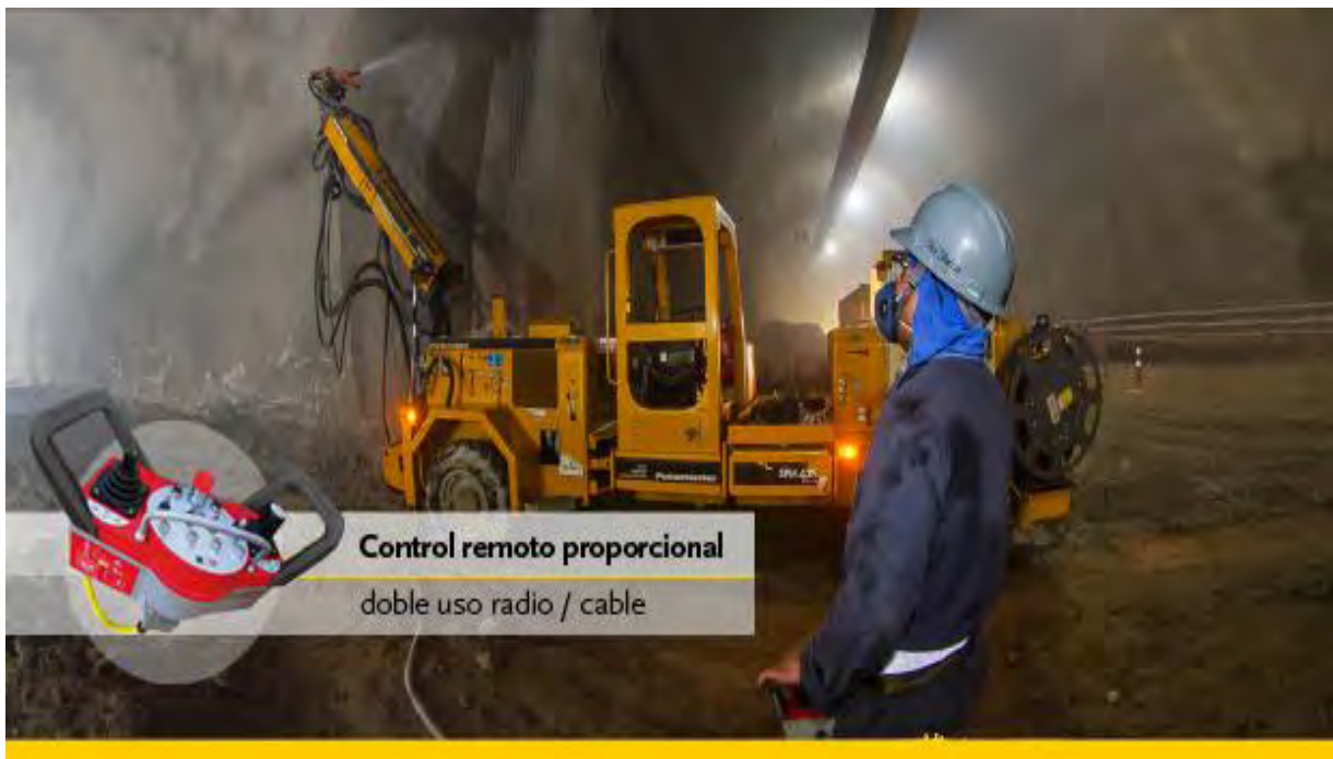
Figura 8: Control del equipo en campo a base de un control remoto (b).
