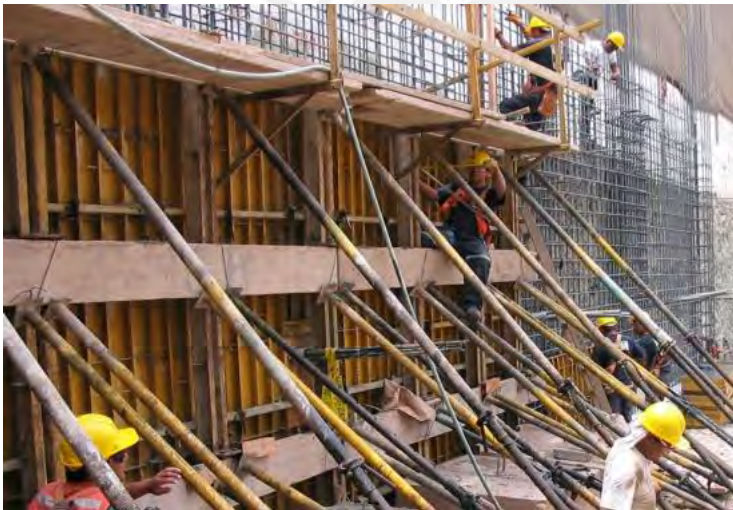
Figura 27. Encofrado del paño del muro anclado.
