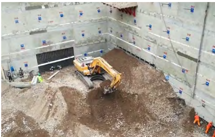
Figura 28. Colocación del terreno para asegurar el encofrado (Pachamanca).
