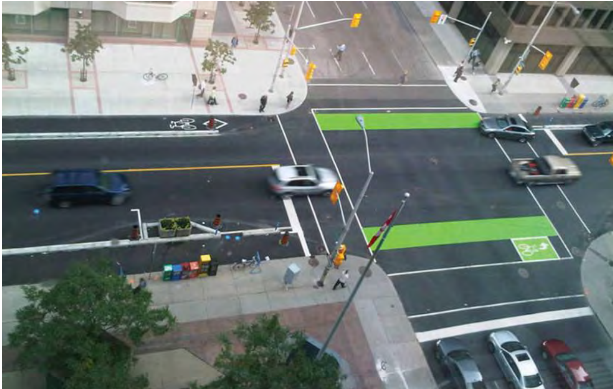
Figura 53 Marcación verde en pavimento.
