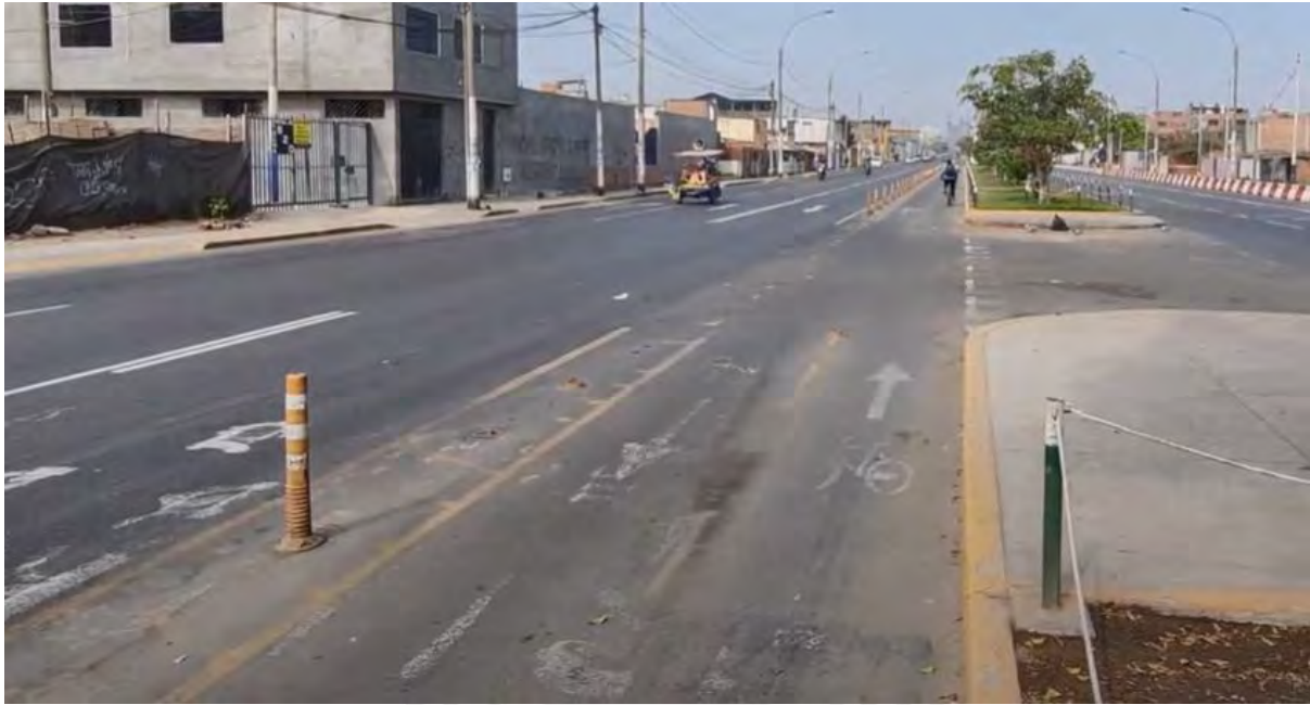
Figura 28 Señal horizontal en ciclovia despintada ubicada entre las intersecciones con Av. Alcázar y Jr. Leoncio Prado.
