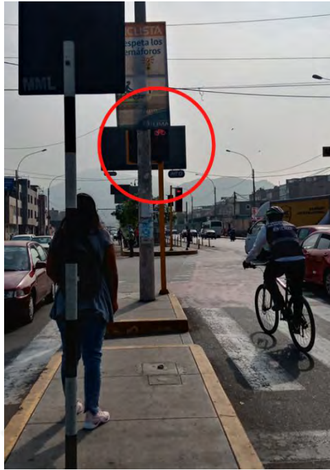
Figura 33 Semáforo ciclista con visibilidad obstruida por cartel ubicado en la intersección 6
