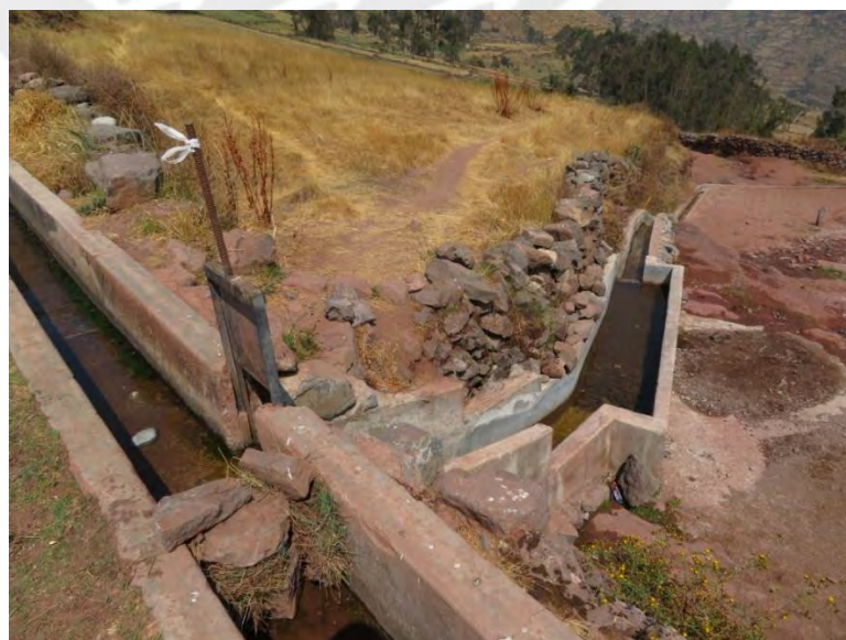
Figura 5.24. Canales de riego desde "La laguna" hacia las parcelas familiares
