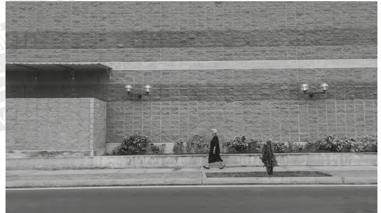
Fig. 3. Centro de datos Cirion Technologies LIM2 (Lurín, Lima). Implantación en parque industrial Macrópolis sobre franja costera desértica con entorno urbano-productivo [arriba]. Fuente: J. Rondan (2025).
