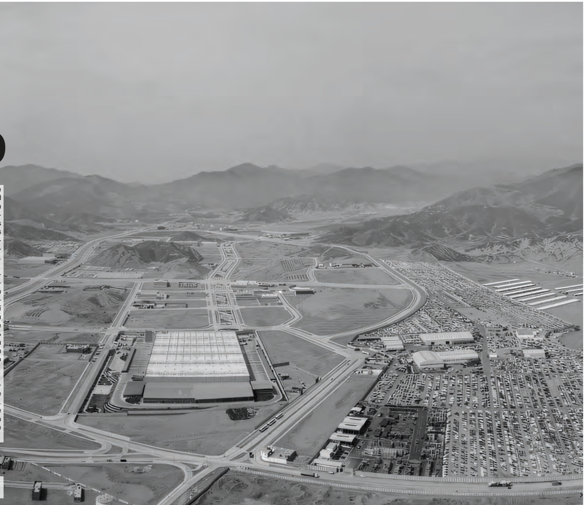
Fig. 59. Zona industrial Macrópolis (Lurín, Lima). Vista aérea. Fuente: Centenario (2025).
