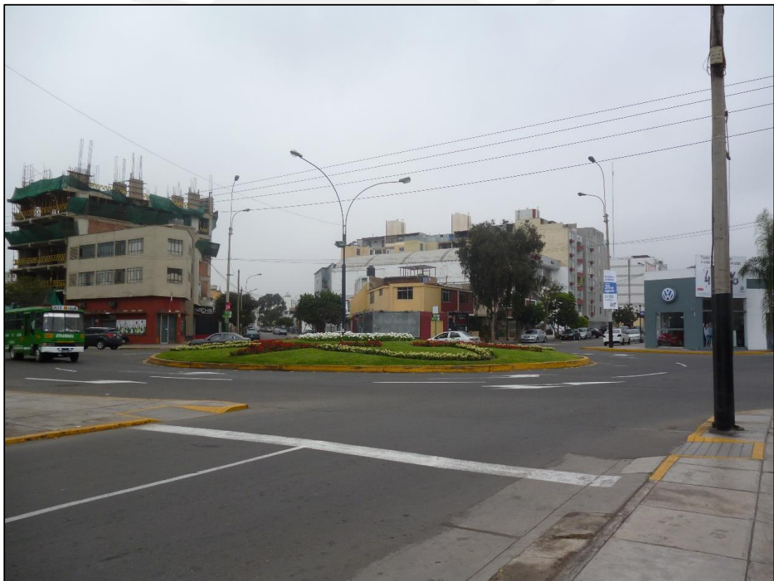
Figura 20. Foto de la rotonda Villarreal. Fuente: propia
