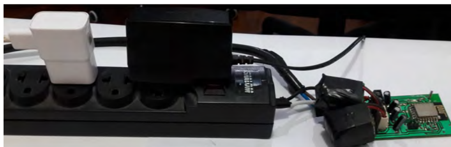
Fig. 4.2: Conexión Regleta - Medidor Fuente propia
