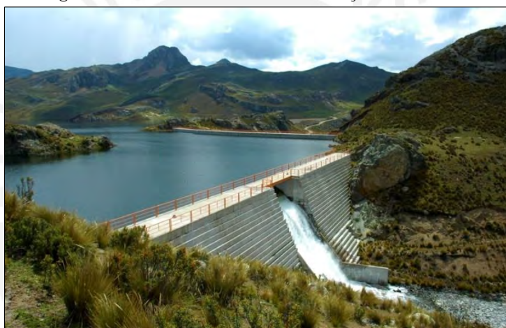
Figura N° 03.- Presa Antacoto – Proyecto Marca III
