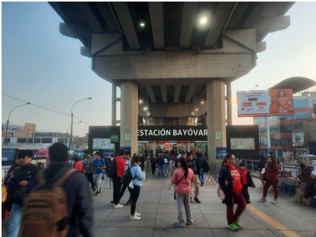
Estación Bayóvar de la Línea 1 del Metro de Lima en SJL
