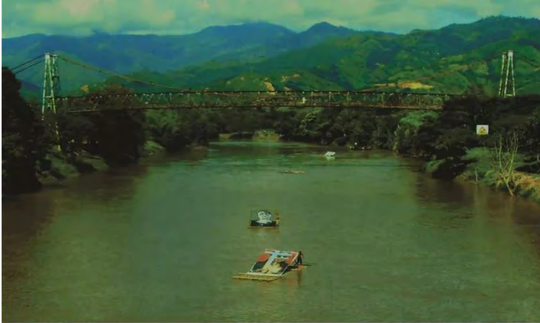
Figura 14. Magdalenas por el Cauca (2008). Pasando por el puente Anacaro.
