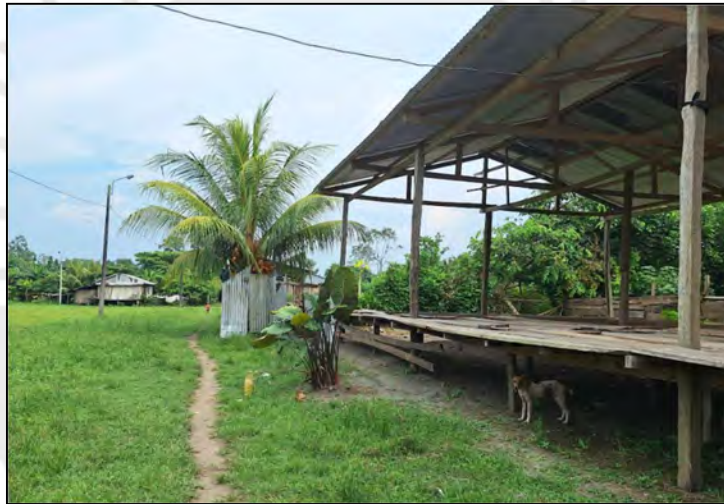
Imagen 36. Vista del tipo de construcción de las casas de la C.N San Pedro, las casas se alzan con vigas de madera aproximadamente a 60cm del terreno para prevenir que en caso de inundaciones el agua entre a las casas Fuente: Visita de campo
