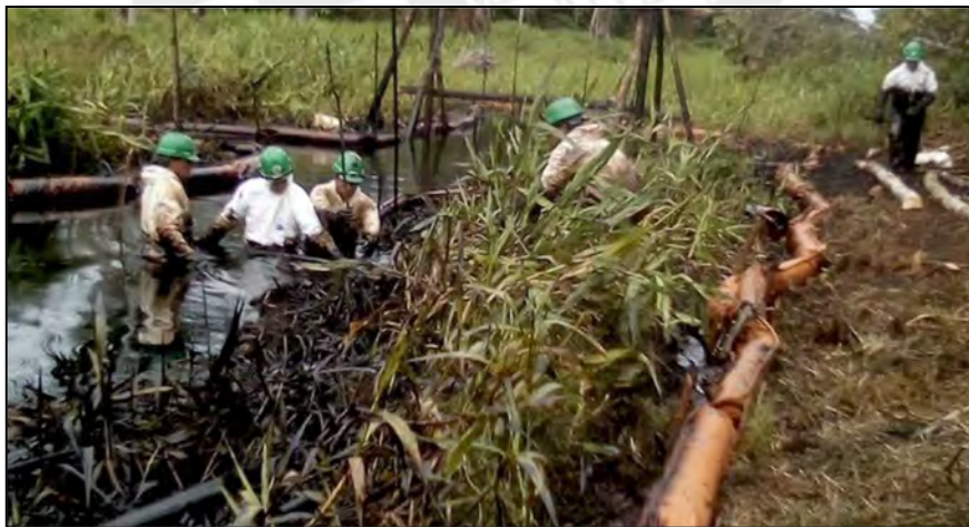
Imagen 3. Colocación de barreras mecánicas para la contención del derrame de febrero de 2018 en el Tramo I del ONP – C.N. San Pedro. Fuente: Romo, 2018
