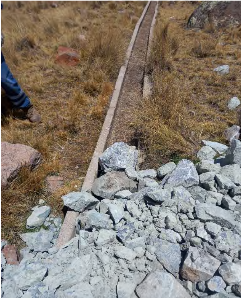
Figura 14. Material del botadero en canal de riego del sector Kachachi, Alto Huarca
