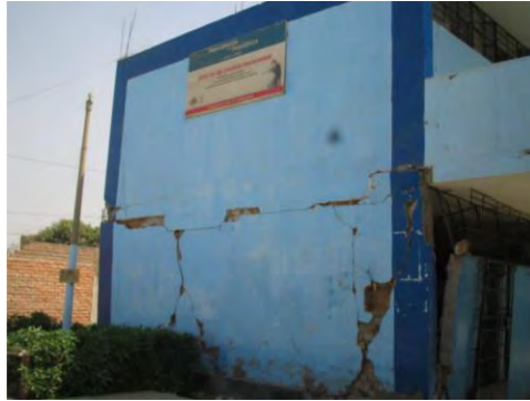
Figura 2.13 - Falla a flexión-corte [3].
