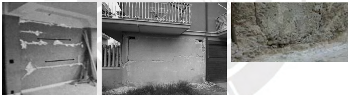
Figura 2.14 - Principales causas de la falla por cizallamiento, a) Junta de construcción muro interior, b) Junta de construcción muro exterior y c) Mala adherencia entre el mortero y ladrillo o sobrecimiento [3].
