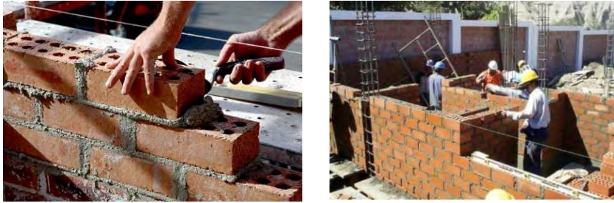
Figura 2.1 - Construcción de edificación con albañilería confinada (Fuente: www.dryhouseperu.com ).
