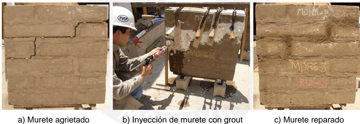
Figura 1.2 Reparación de muretes con inyección de grout de barro (Blondet et. al 2007)
