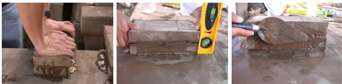
a) Obtención del espesor del grout b) Regulación del aplomo c) Enrasado del emparedado
