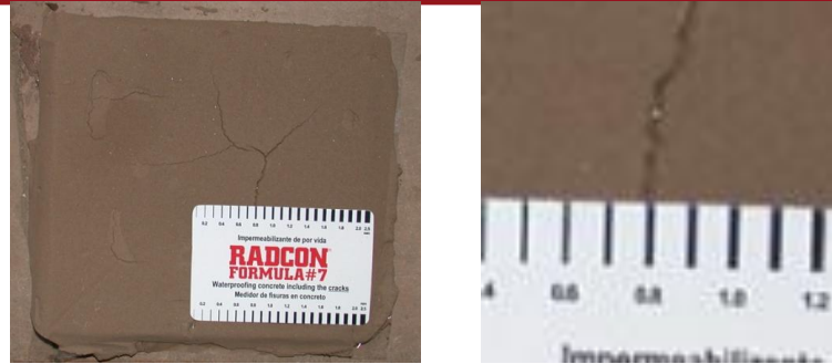
b) Medición del ancho de fisuras con la tarjeta medidora de fisuras
