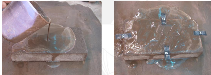
a) Colocación del grout b) Colocación de topes de junta
