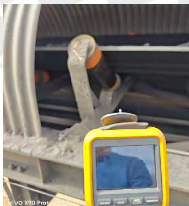
Figura 5.7: Verificación en el sitio con una cámara termográfica
