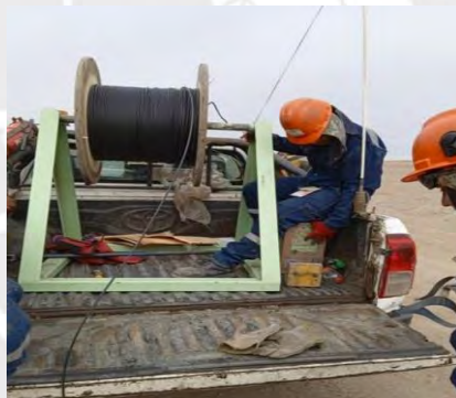
Figura 4.10: Tendido del cable fibra óptica a lo largo de la faja transportadora de mineral.
