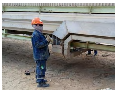
Figura 4.11: Tendido del cable fibra óptica por las bandejas
