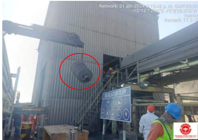
Figura 5.11: El día 21/04/2024, desmontaje de la polea N°9 de la faja transportadora de mineral
