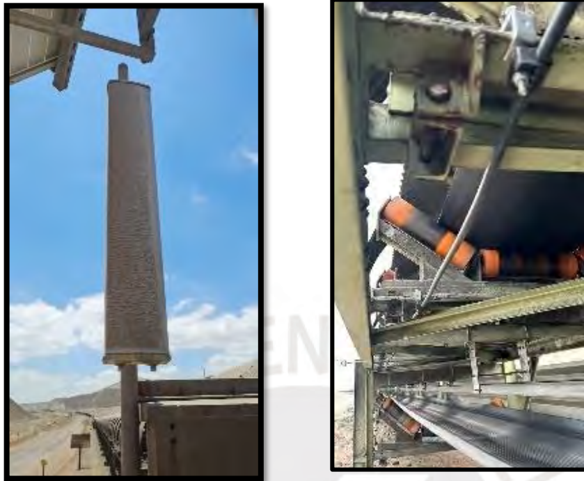
Figura 4.16: Lado izquierdo se muestra las antenas (antes) en lado derecho el después (cable coaxial )
