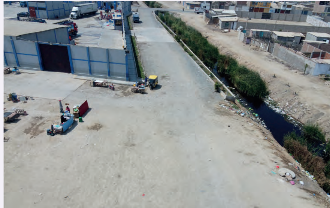
Vista aérea del terminal próximo al dren 4000 Fuente: Fotografía propia, 2024.
