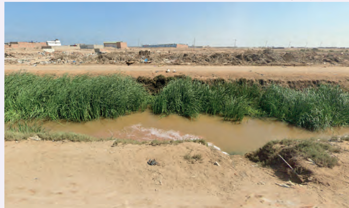
Vista Dren 4000 con residuos de la laguna de oxidación. Fuente: Google Street view, 2023.
