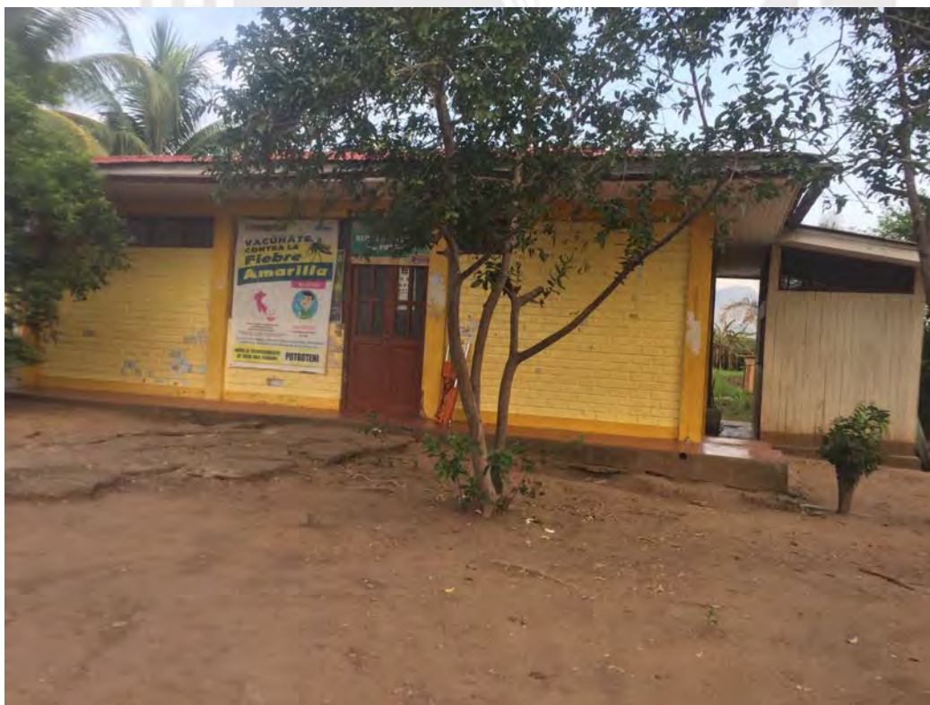
Fotografía 2: Puesto de Salud de la CCNN Potsoteni y baños
