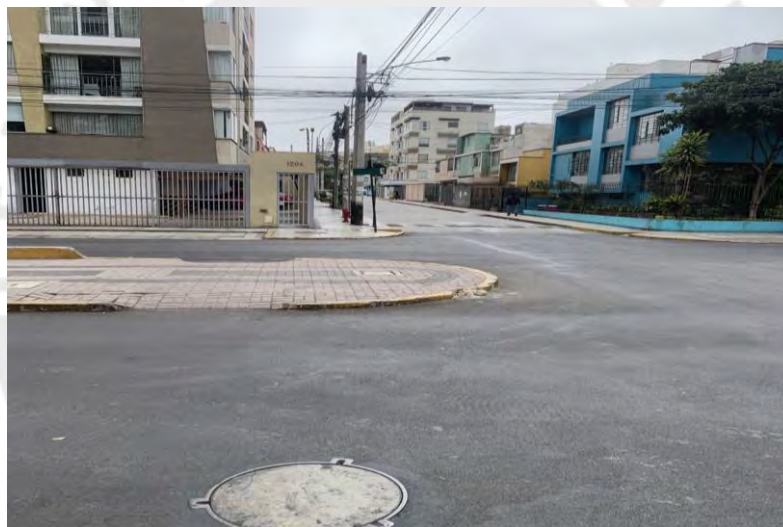
Figura 14: Falta de señalización horizontal en la intersección
