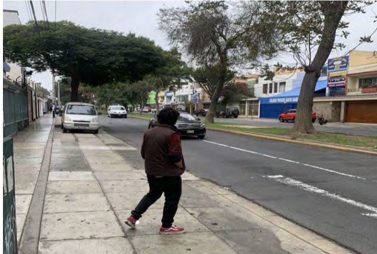
Figura 13: Desgaste en la señalización horizontal de la avenida principal
