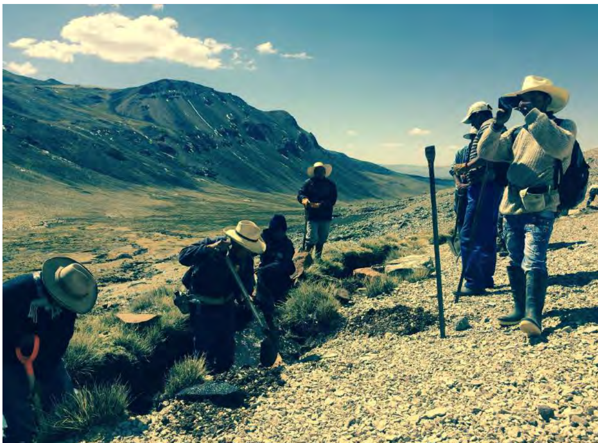
Imagen 35: Representante municipal fotografía las faenas de limpieza. Captura de autor
