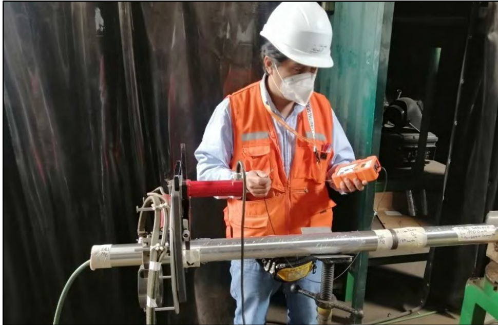
Figura 55. Verificación de la evacuación de oxígeno al interior de la tubería.
