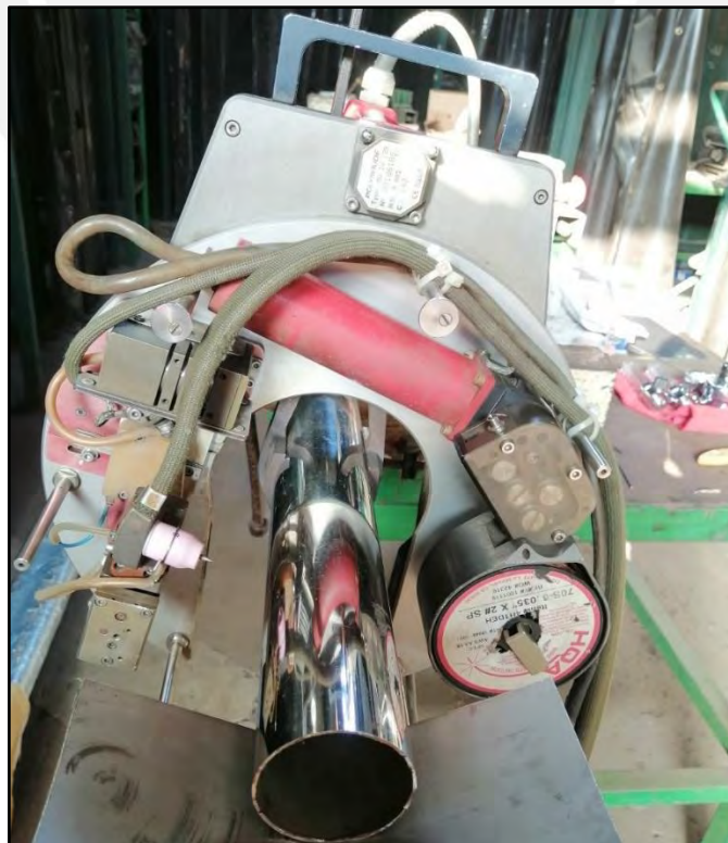
Figura 39: Pre Montaje en taller del cabezal MU IV 128 en la tubería de 2,5" \varnothing .
