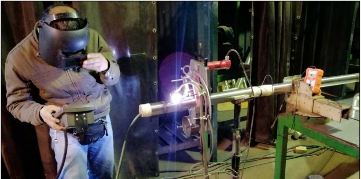
Figura 61. Inicio de soldadura autógena orbital TIG pulsado con el telemando a distancia.
