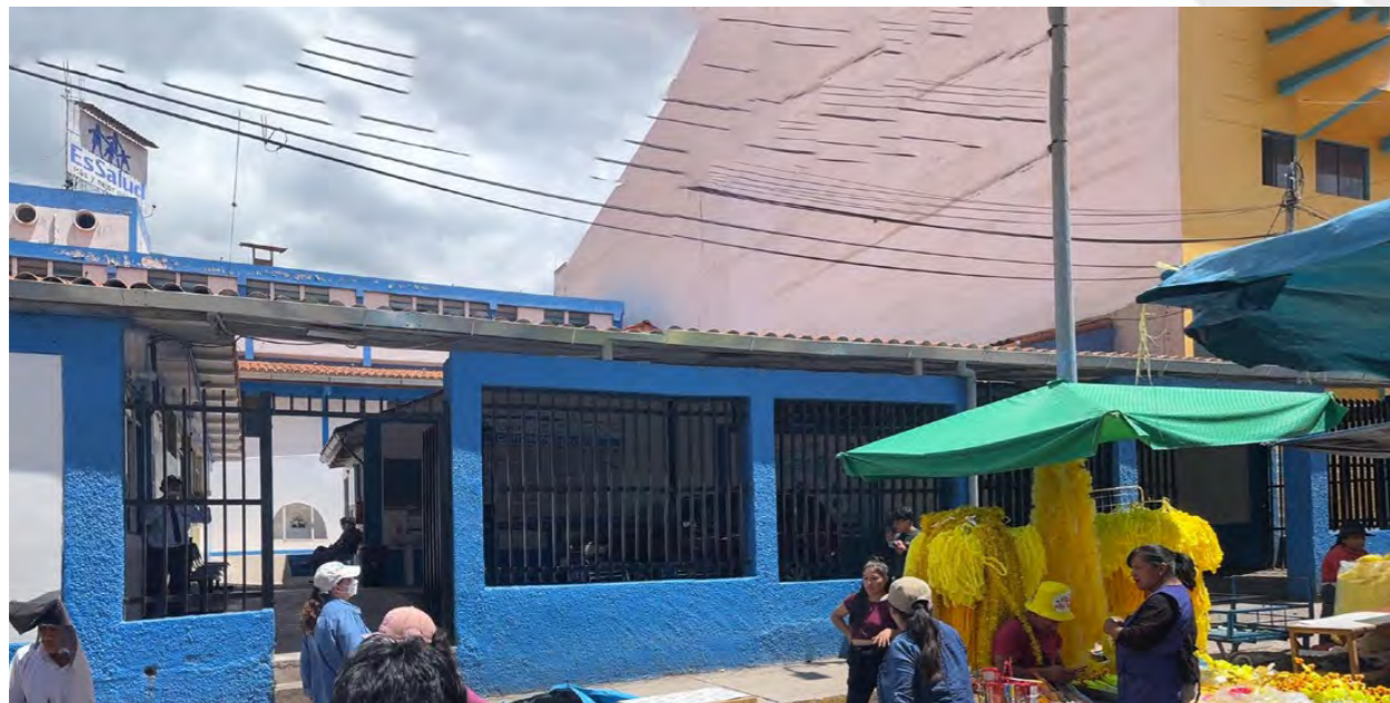
Fig 16. Fachada del Hospital de EsSalud Fotografía propia
