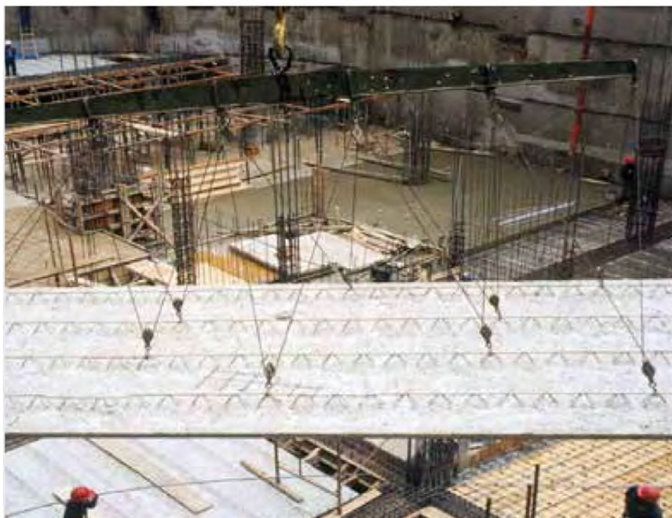
Figura 13. Modelo de instalación de prelosas macizas
