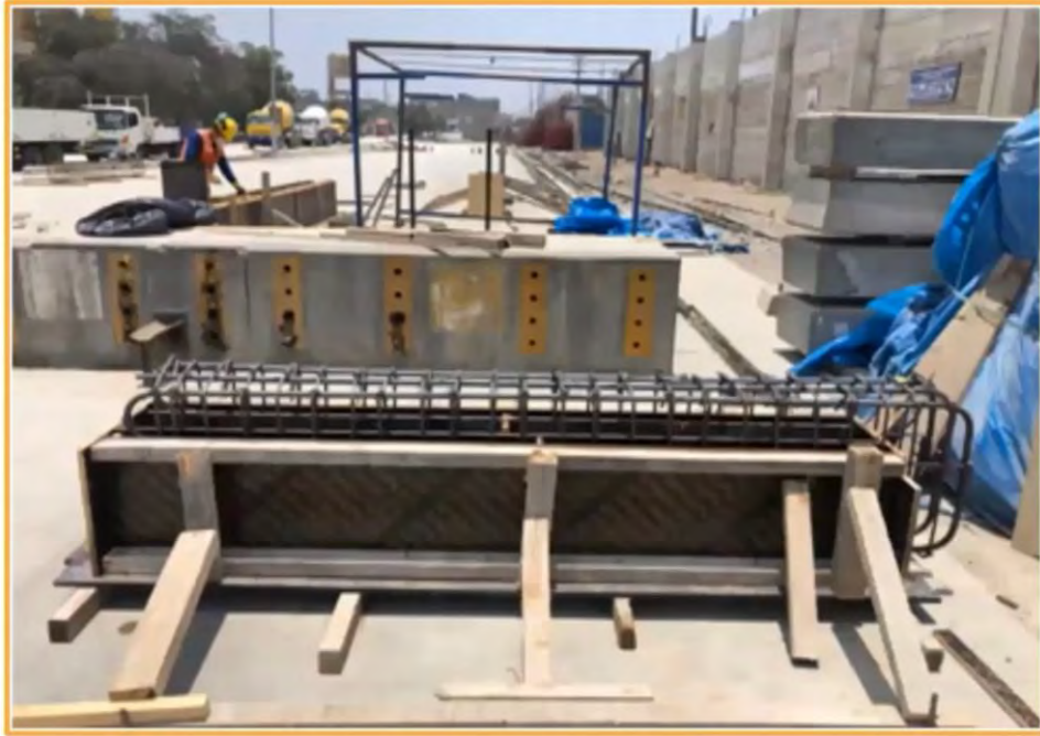
Figura 56. Colocación de moldes para previgas
