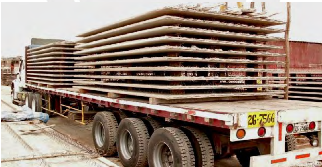
Figura 74. Transporte de prelosas hacia la obra
