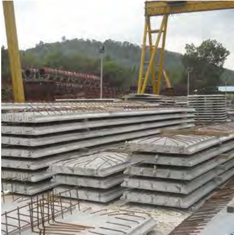
Figura 71. Apilado de prelosas macizas
