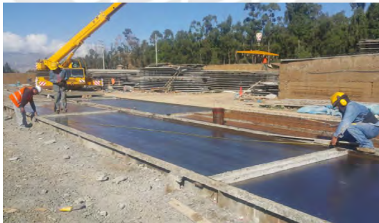
Figura 66. Trazado y encofrado de prelosa
