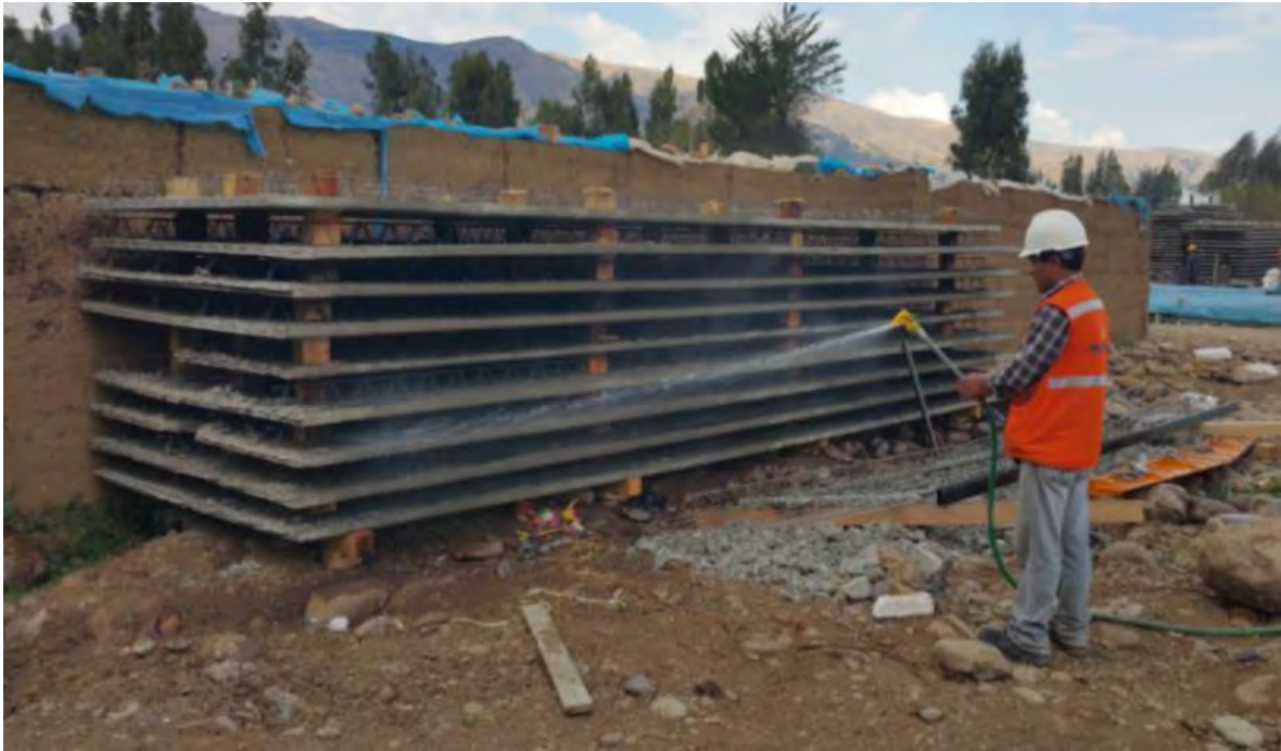
Figura 73. Curado de prelosas
