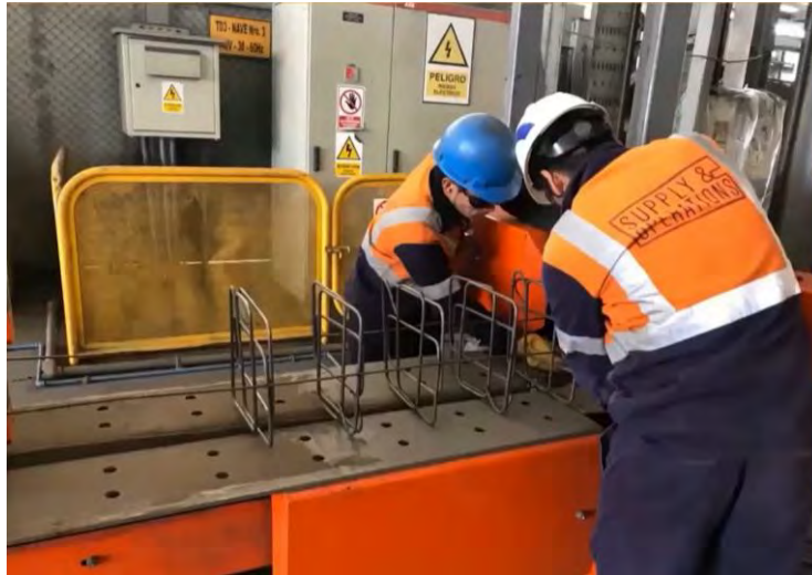
Figura 50. Montaje de aceros en una previga
