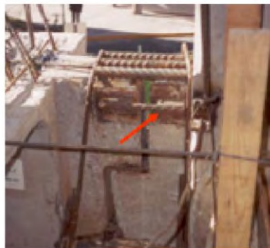
Figura 21. Conexión soldada en el lecho superior.
