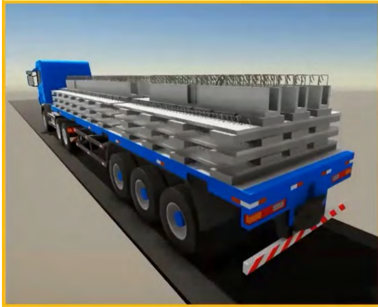
Figura 58. Transporte de previgas a obra
