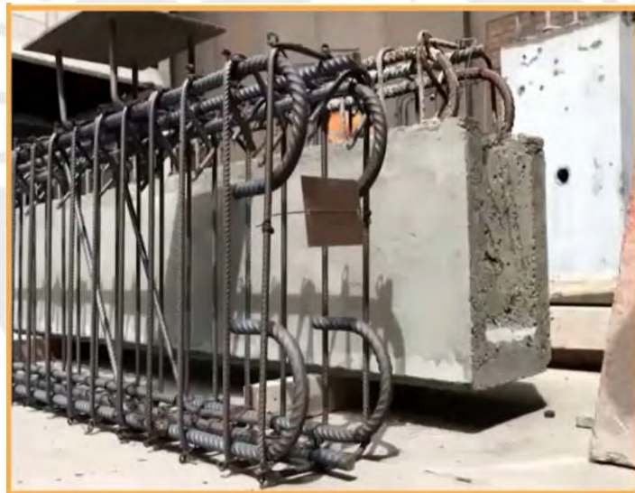
Figura 57. Vaciado de concreto en previga
