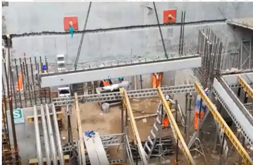
Figura 63. Colocación de previga en obra
