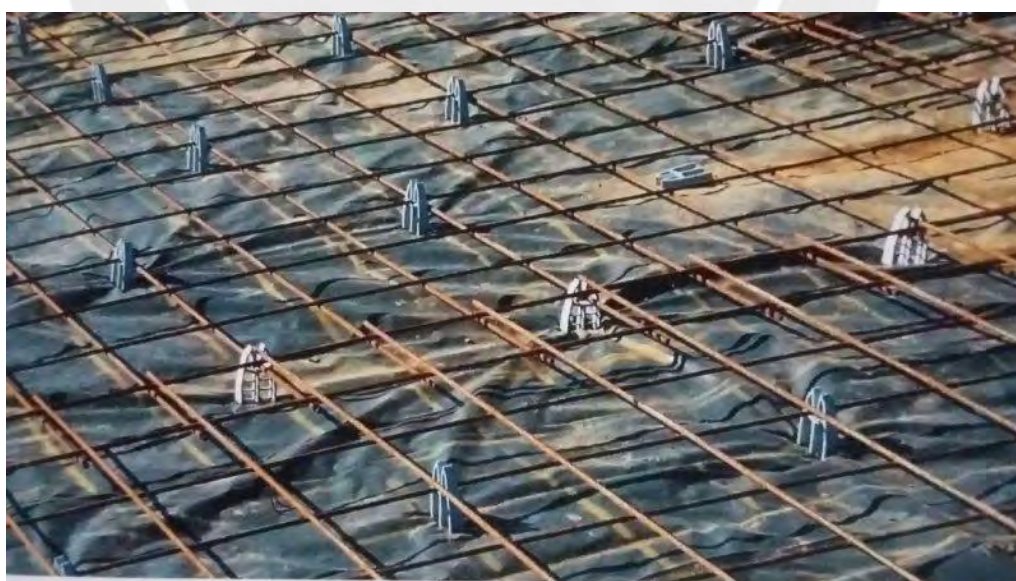
Figura 68. Colocación de separadores en prelosa
