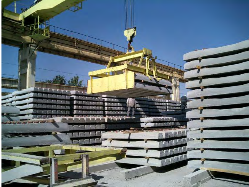
Figura 70. Desmoldaje de una prelosa
