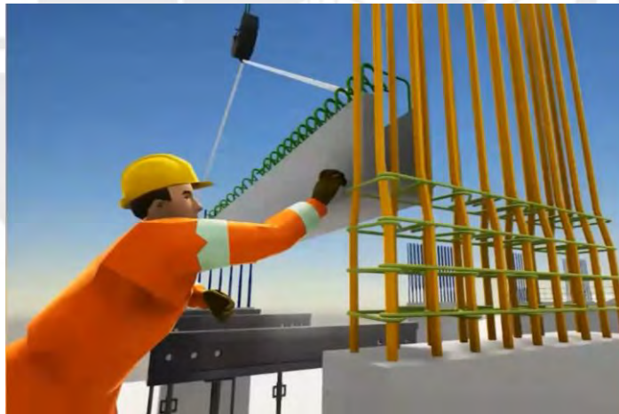
Figura 59. Montaje de previga
