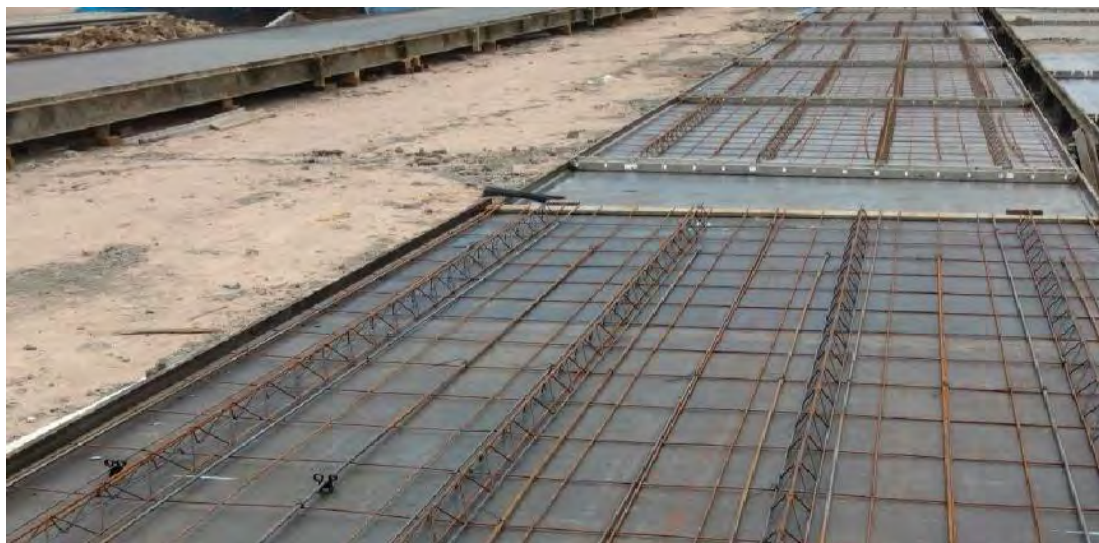
Figura 67. Instalación de acero en prelosa
