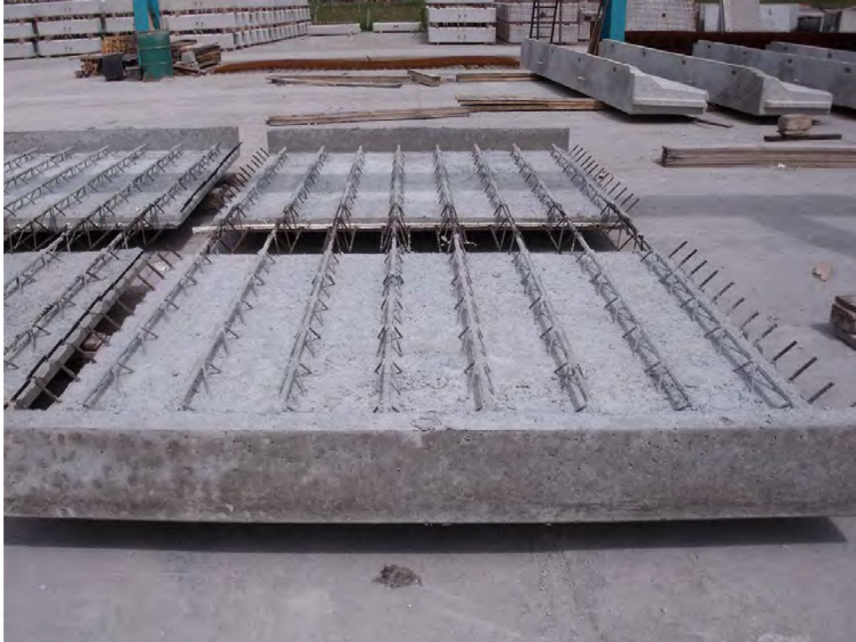
Figura 69. Vaciado de concreto en prelosa
