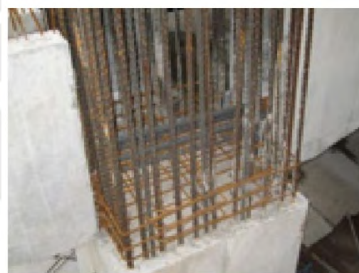
Figura 23. Conexión emulativa del concreto reforzado.
