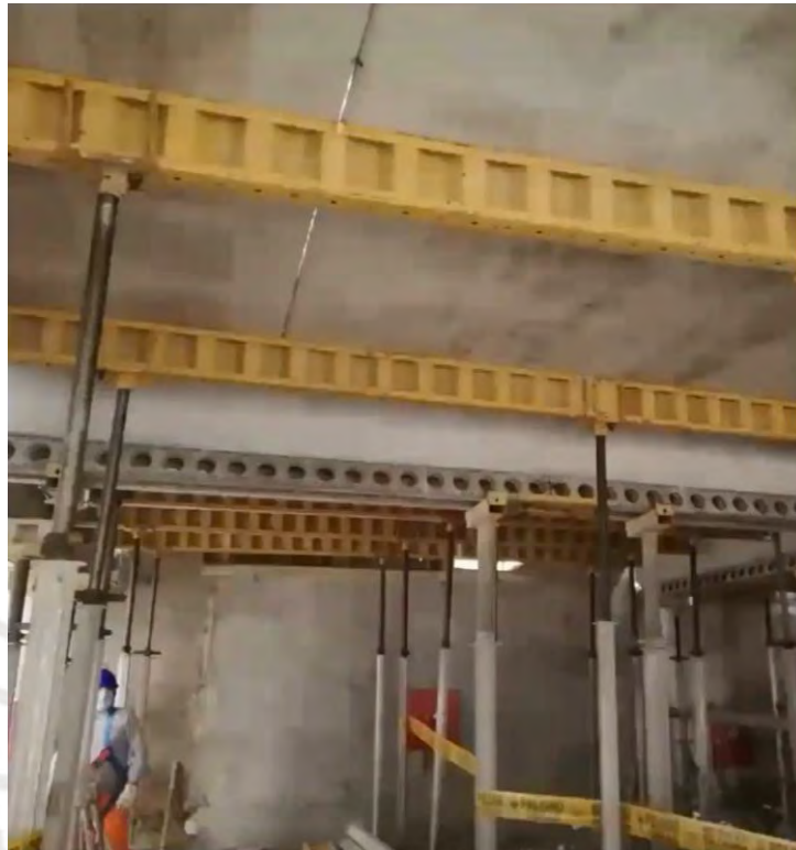
Figura 64. Vaciado y apuntalamiento de previgas
