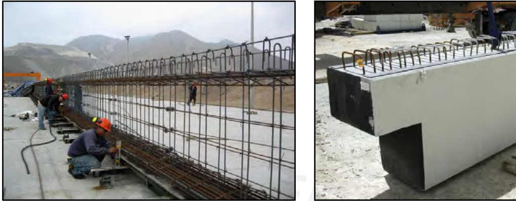
Figura 2.2. Armado de Viga Jácena pretensada y estado final (Tecnyconta, n.d)
