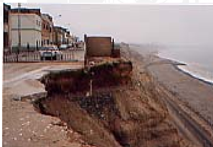
Vista de la corona del talud. El muro ha sido removido . 10 de marzo del 2002
