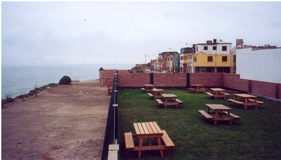
Jardín-Comedor cercano al borde del talud.
