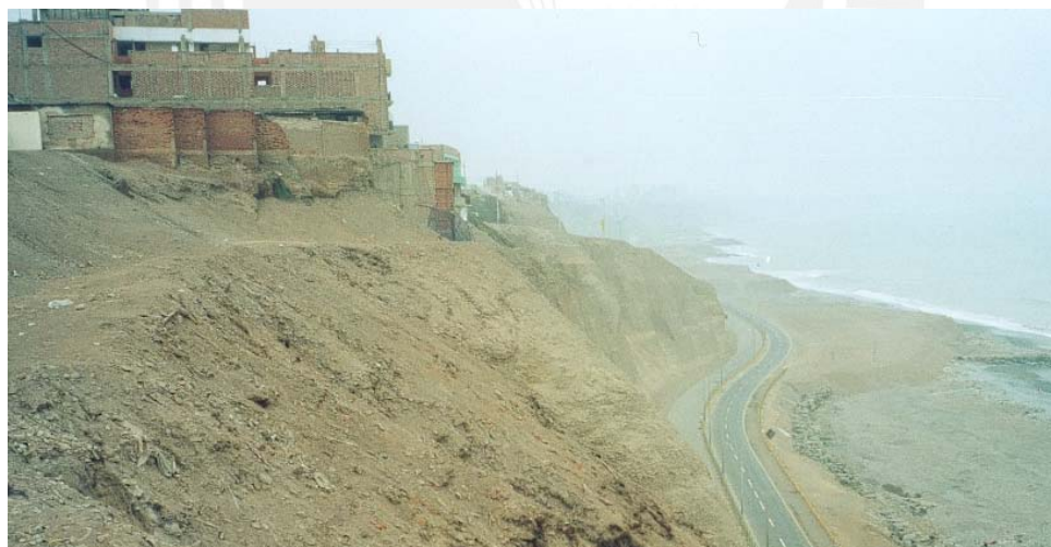
Vista de la corona del talud, en la cual se aprecia la casa al borde
