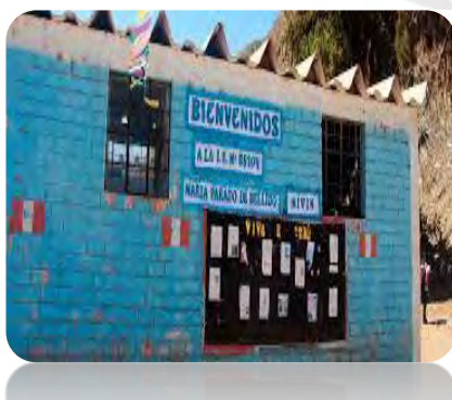
I.E. 88104 María Parado de Bellido antes de la refacción
