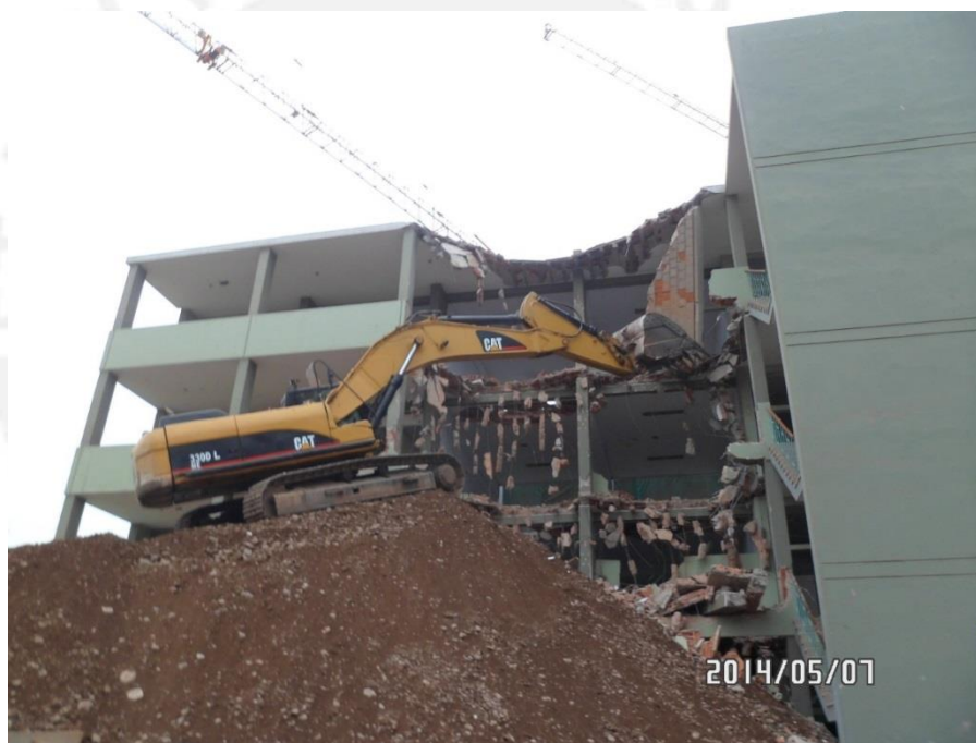
Figura 2: Demolición parcial del antiguo Pabellón B de la PUCP
