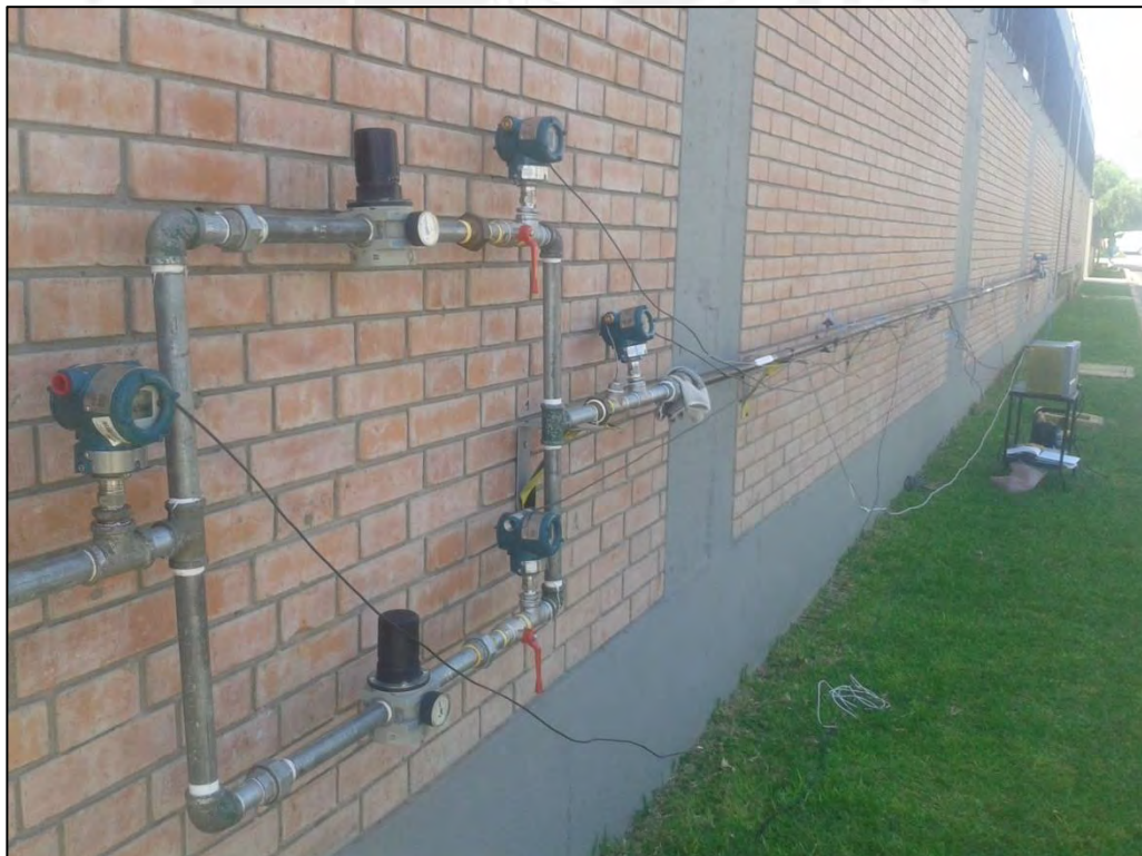
Fig. 2.15: Instalación de línea de pruebas
