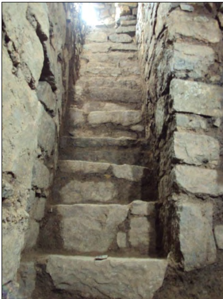
Figura 5.26. Vista interna de la escalera ES.AS.
