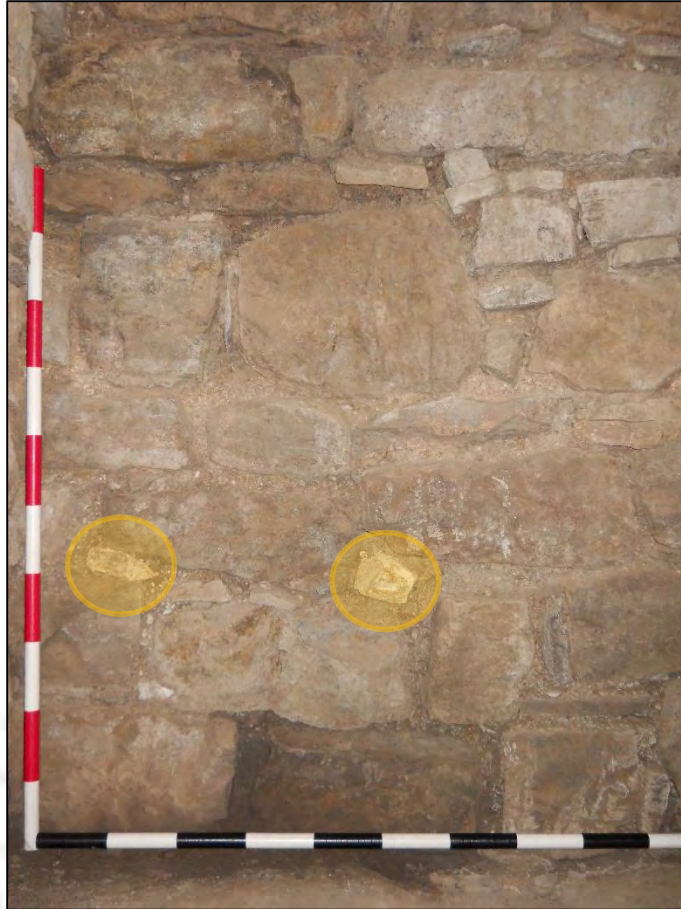
Figura 6.14. Vista frontal de la pared RL.02-E. Detalle de la alineación de rocas calizas.
