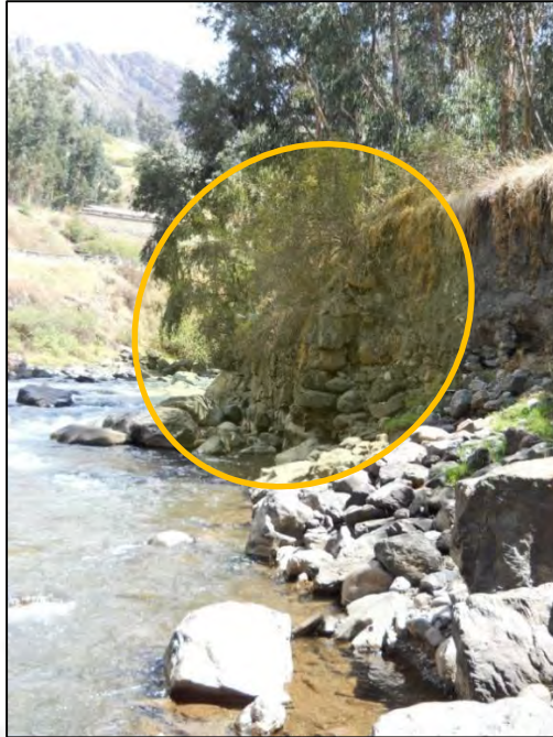
Figura 5.2. Muro ciclópeo en la margen izquierda del río Mosna.
