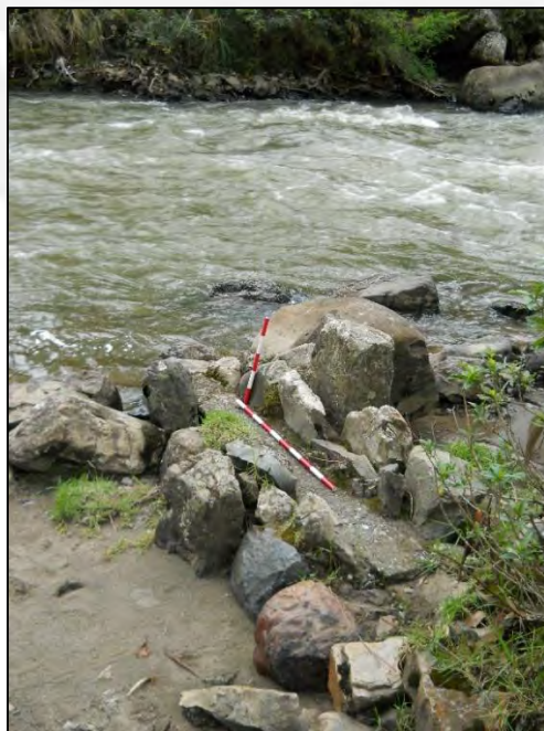
Figura 5.17. Canal que desembocan en el río Mosna que posiblemente corresponda al Canal de Rocas.
