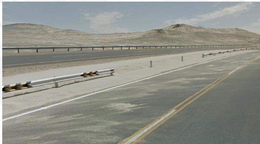
Figura 41. Presencia de arena en la plataforma de la vía. Fuente (Propia)
