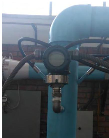
**Figura 28. Sensor de presión para bajas presiones.**
