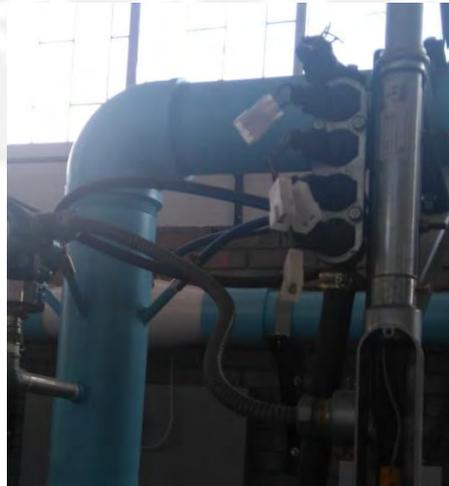
**Figura 20. Sistema de inyección de GNV.**
