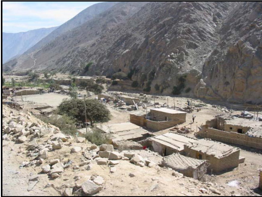
Foto 5 Vista general de la zona de trabajo en Relave
