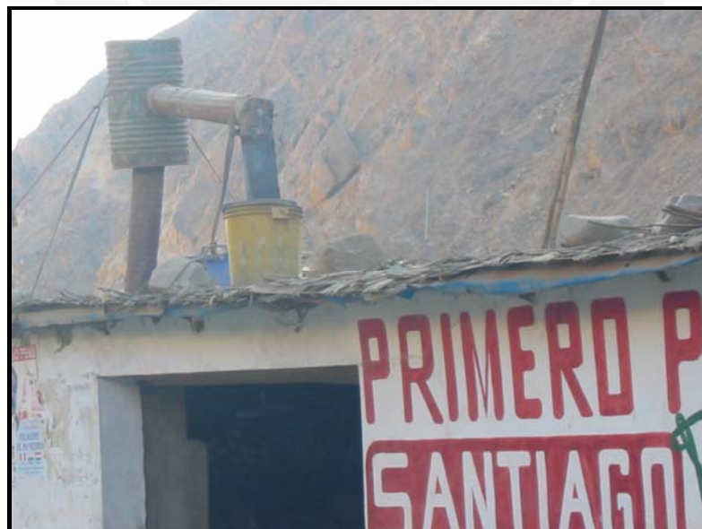
Foto 4 El proceso de “refogeo” se hace en el interior de los hogares, nótese la chimenea artesanal, el uso de la cubeta amarilla es para colocar agua y así evitar que el humo se condense
