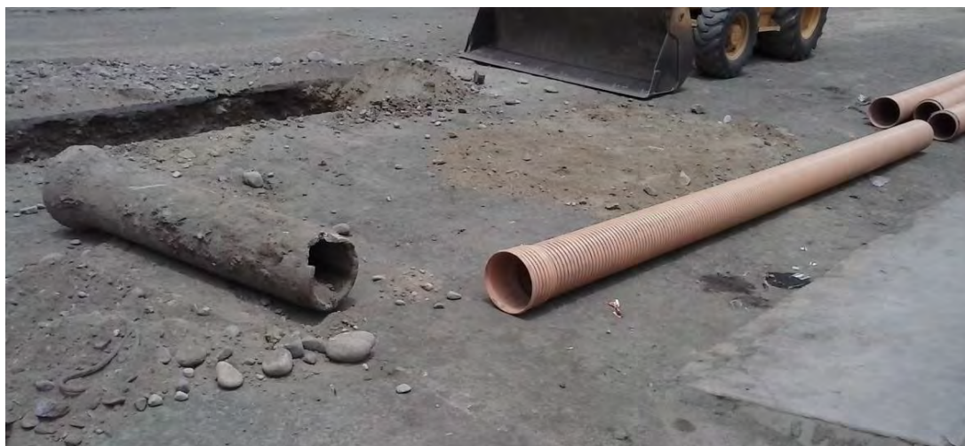
Foto 4.7: Tubería reemplazada y nueva percibida por los vecinos como un cambio en sus vidas luego del proyecto Lote 3
