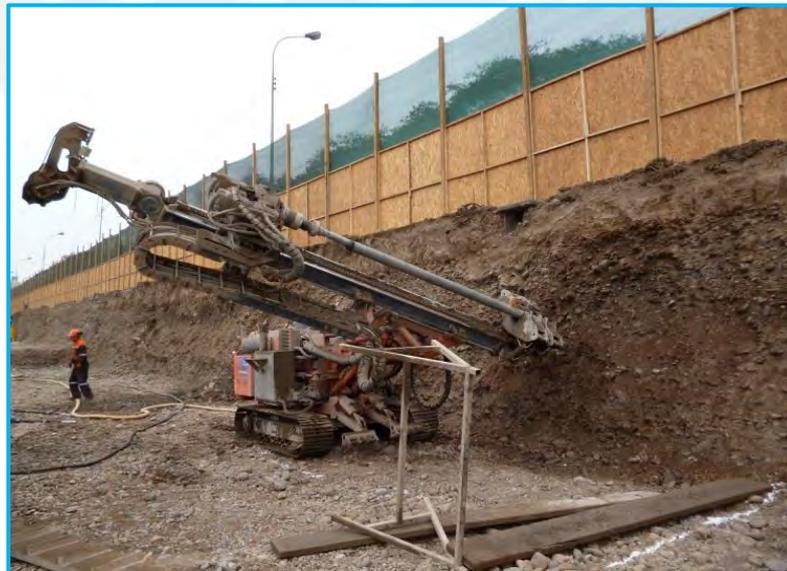
Fotografía 4.3 Perforación, colocado de cables metálicos e inyectados de grout.
