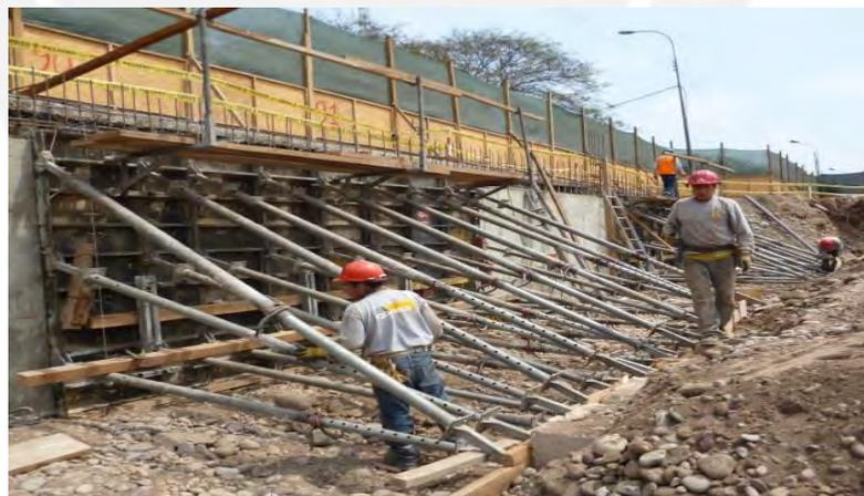
Fotografía 4.9 Puntales apoyados en los bloques de concreto.
