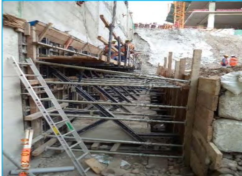
Fotografía 7.12: Encofrado con contención de concreto
