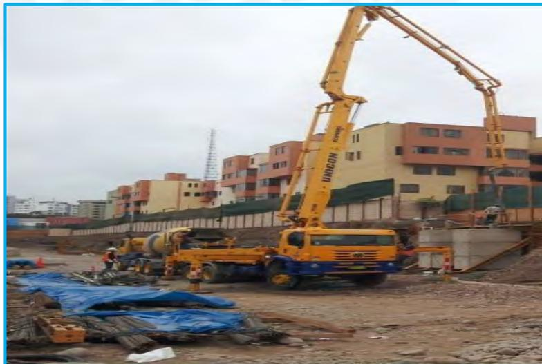
Fotografía 4.13 Vaciado del concreto en los muros.
