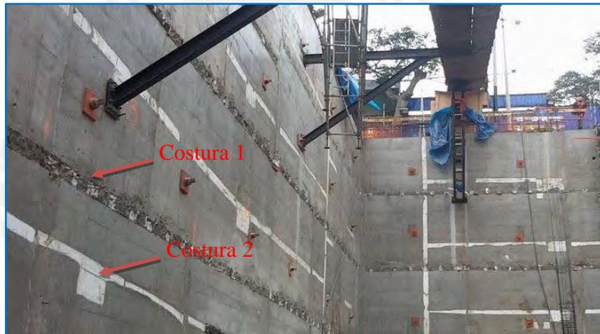
Fotografía 7.1. Panorama del avance de construcción de muros
