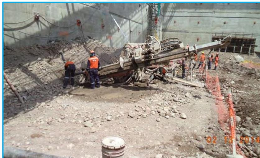
Fotografía 7.8. Perforación de cables e inyección de lechada
