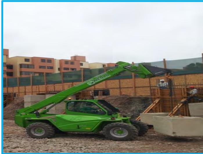
Fotografía 4.10 Maquinaria Merlo trasportando bloques de concreto.
