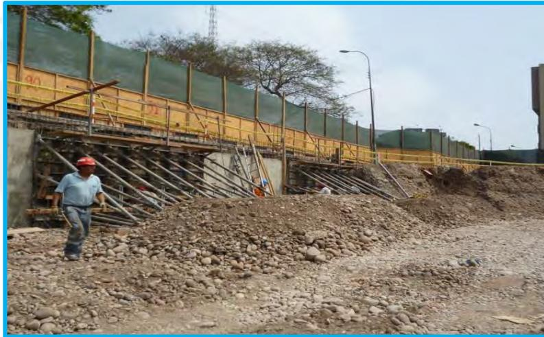
Fotografía 4.11 Puntales apoyados en bloques de concreto enterrados
