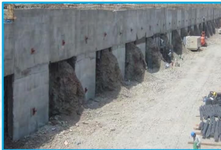
Fotografía. 4.1 Muros del segundo anillo en el estado inicial, mientras los muros del primer anillo se encuentran en el estado intermedio.
