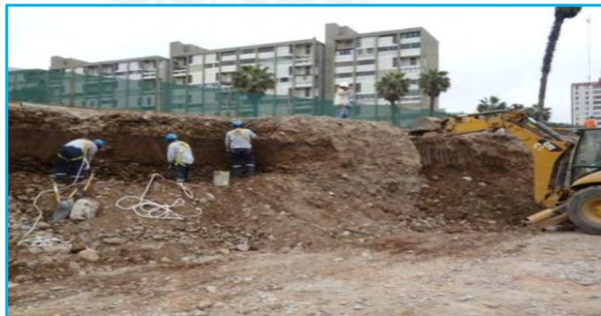
Fotografía 4.5. Obreros perfilando manualmente el talud.
