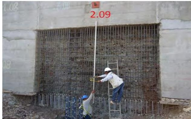
Fotografía 7.5 : Colocación de protección de acero. (Fuente: Elaboración Propia)
