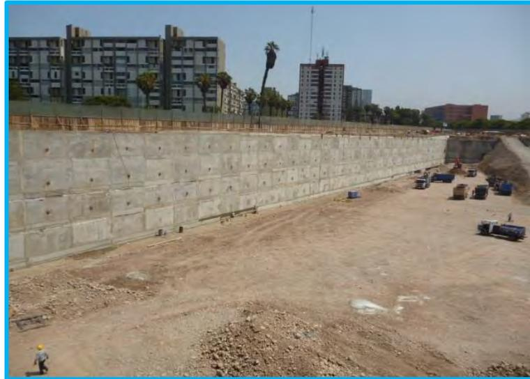
Fotografía 4.16 Demostración 4 anillos de muros anclados.
