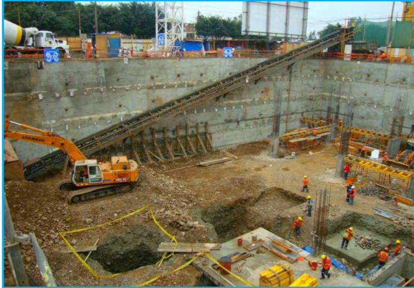
Fotografía 7.4 Las fajas transportadoras pueden trasladar el material de excavación directamente a un volquete en el exterior sin necesidad de utilizar una rampa.
