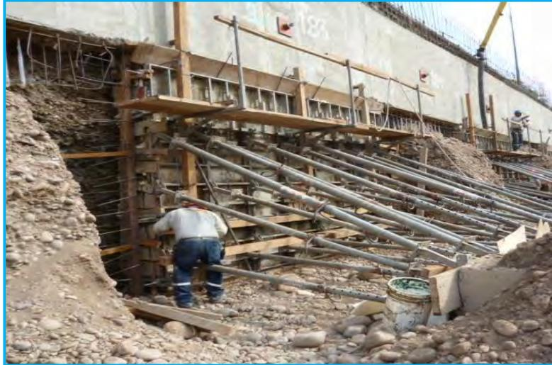
Fotografía 4.12 Madera de contención ya colocada. En la parte superior del muro se puede apreciar el chute de madera.
