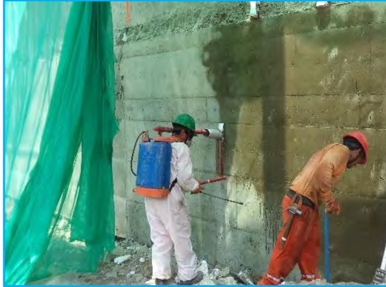
FOTOGRAFIA 7.14: Curado del muro recién vaciado
