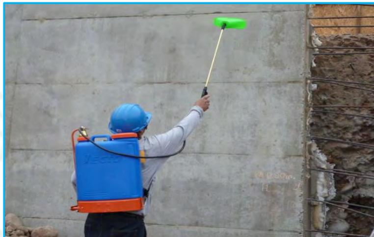
Fotografía 4.14 Curado del concreto de los muros
