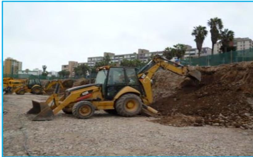
Fotografía. 4.4. Retroexcavadora cortando las bermas donde se va a construir los muros.
