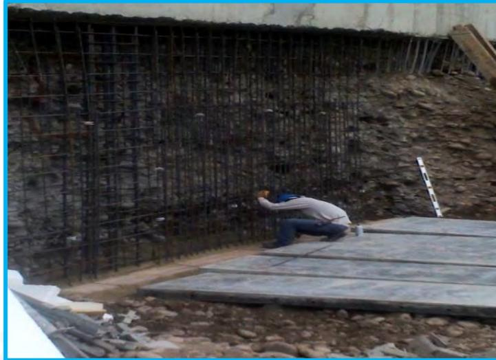
Fotografía 4.6 Instalación de mallas de acero en los muros. Se puede apreciar los paneles fenólicos listos para colocar.
