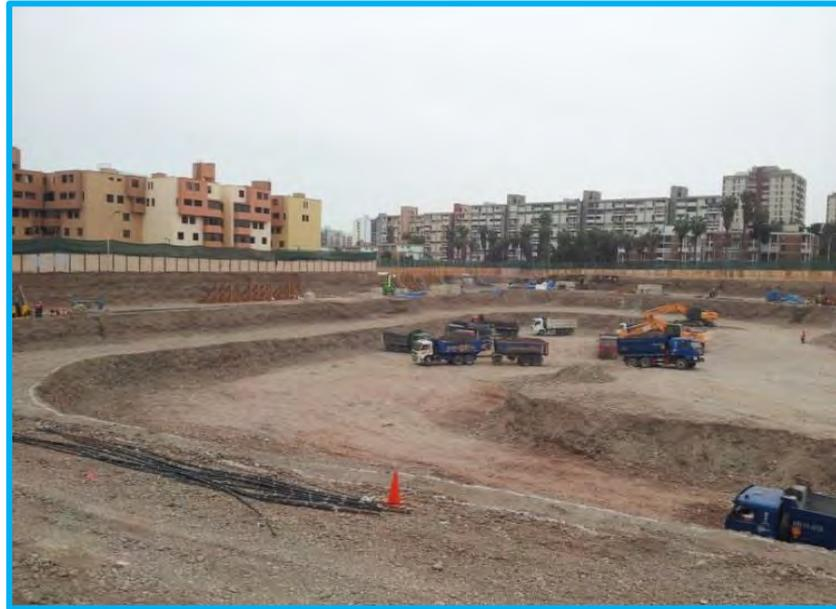
Fotografía 4.2 Excavación masiva del primer y segundo anillo con bermas de seguridad.
