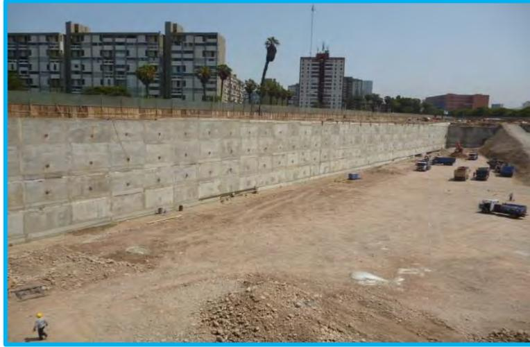
Fotografía. 3.1. Aplicaciones de muros anclados
