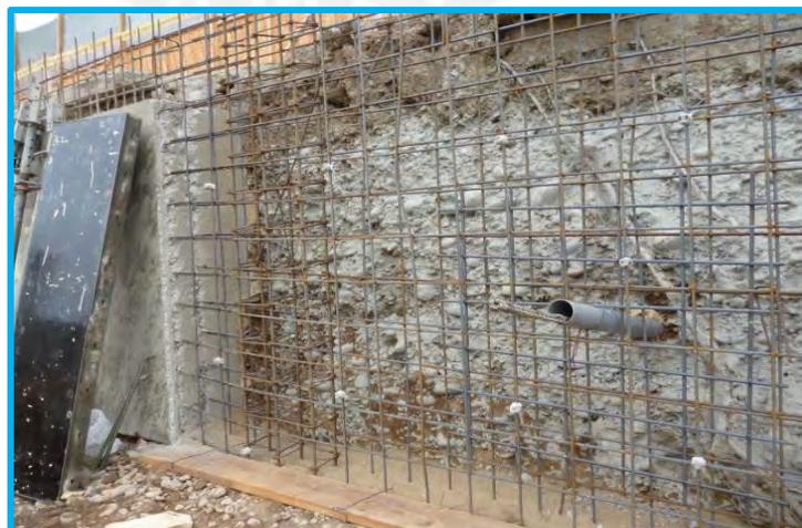
Fotog.4.7 Colocación de tabla de madera apoyo para el encofrado.
