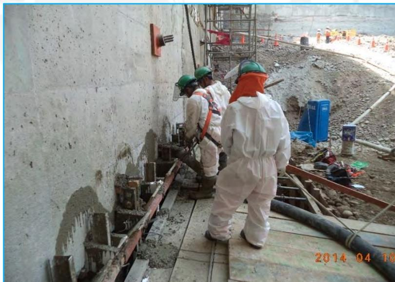
Fotografía 7.13: Vaciado de concreto de cada paño
