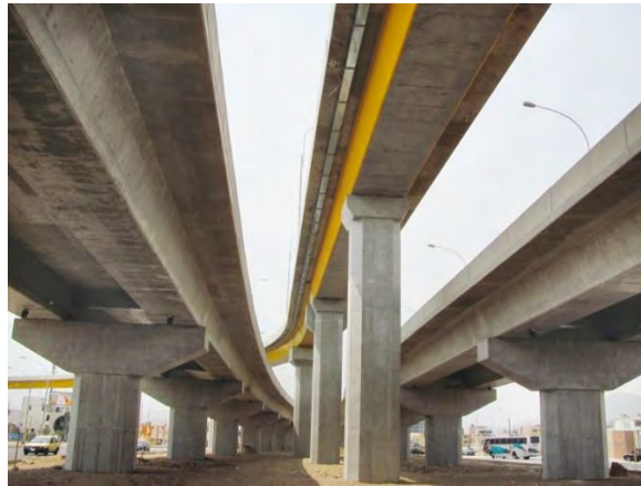
Figura 7.3 Vista inferior del intercambio vial ( www.construcciónyvivienda.com )
