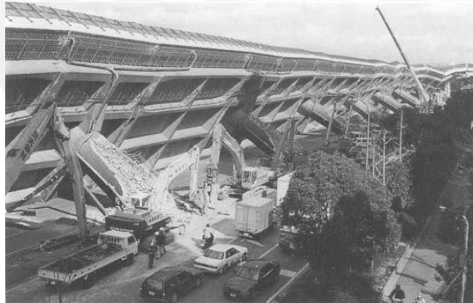
Figura 2.13 Falla por flexión en el sismo de Kobe [6]
