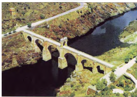
Figura 2.2 Puente integral de mampostería [1]
