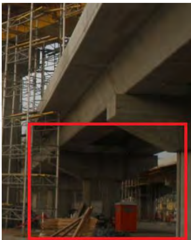
Figura 7.58 Vista del tramo norte-sur ( www.construcciónyvivienda.com )
