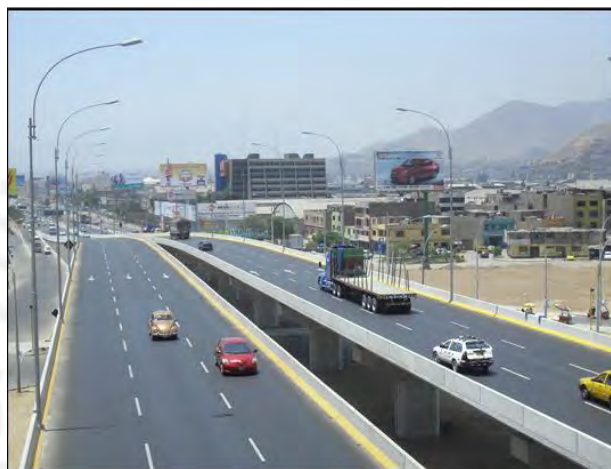
Figura 7.4 Vista superior del puente Norte-Sur ( www.emape.s.a )
