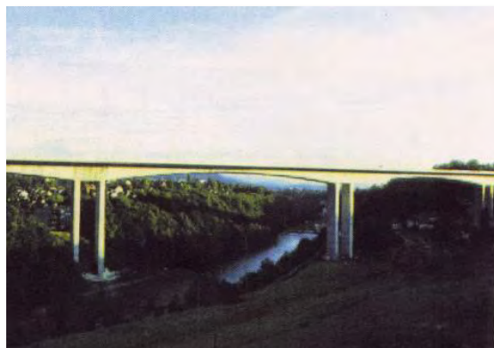
Figura 2.3 Puente semi-integral por voladizos sucesivos [1]
