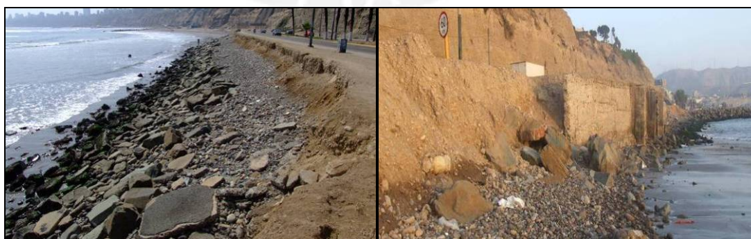
Fig. 19: Dismantelamiento incipiente del terraplén costero en sector sur playas Los Yuyos (der.) y Barranco (izq.) (fotografía propia 2007)
