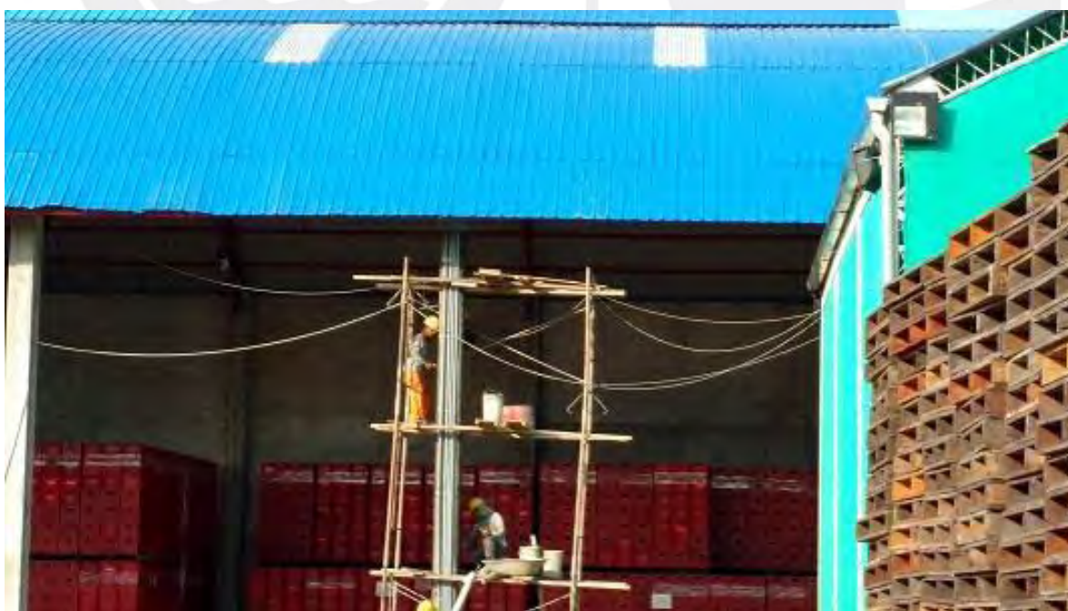
Figura 4. En plena construcción del almacén para la estiba de cajas de cerveza y pallets.
