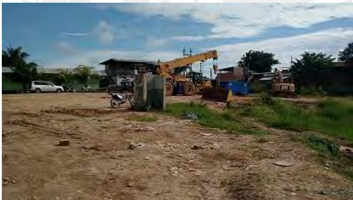
Figura 2. Vista de las instalaciones cuando inició el proyecto (al fondo se puede observar el lugar en donde se construirá el almacén).
