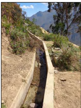
Canal revestido para la distribución del agua de riego para las parcelas.
