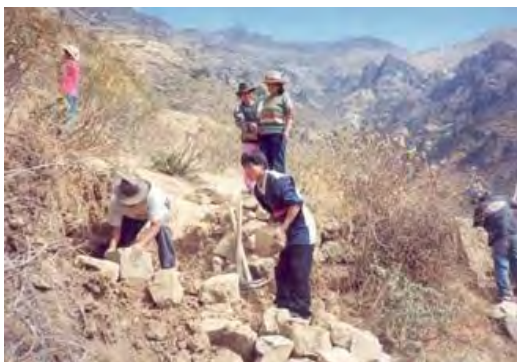
Figura 33: Limpieza del terreno y desmontado del muro caído
