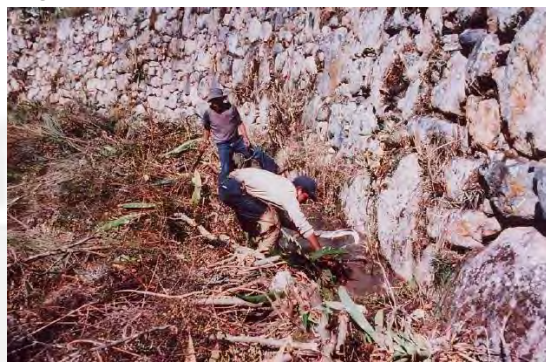
Figura 34: Acondicionamiento del sistema de riego
