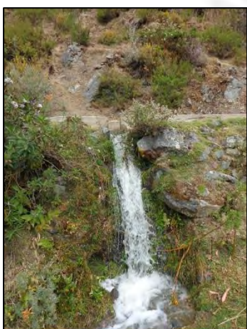
Canal de distribución que sale del reservorio Shicacocha.
