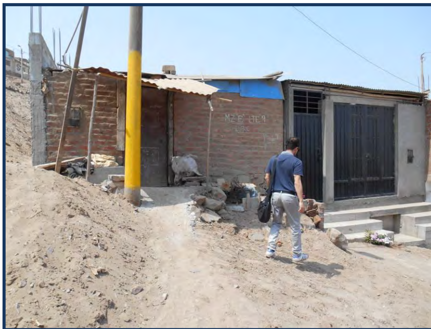
Foto 4.1. Viviendas de Carabayllo
