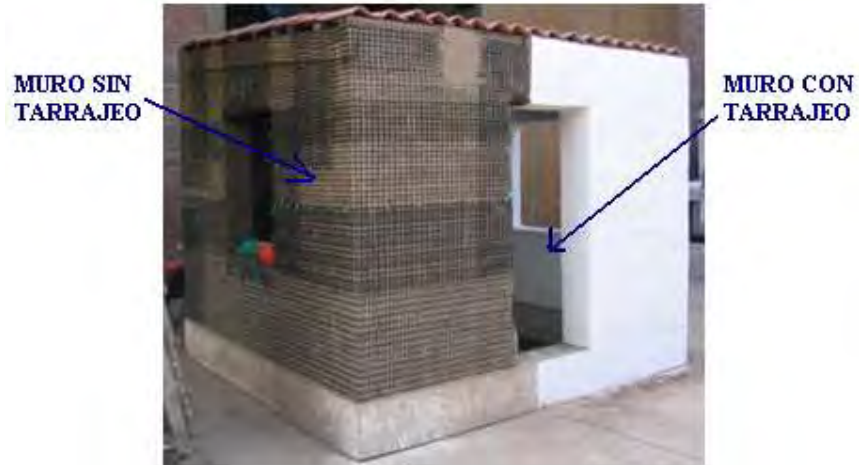
Figura 5.1 Muro de adobe con refuerzo de geomalla M5
