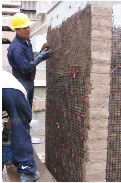
c) Tarrajeo del muro
