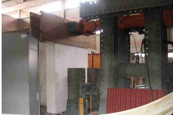
Figura 4.6 Ubicación del actuador la parte superior del muro.
