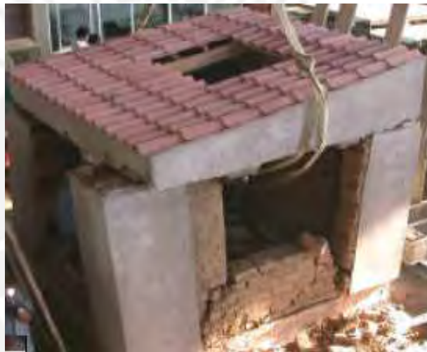
Figura 2.9 Estado final del modulo M3 (Fase 6)
