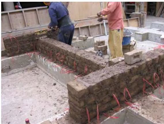
a) Asentado de muro y colocación de rafia
