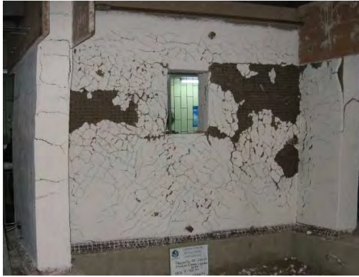
Figura 4.16 Muro con geomalla antes de retirar el tarrajeo (después del ensayo).
