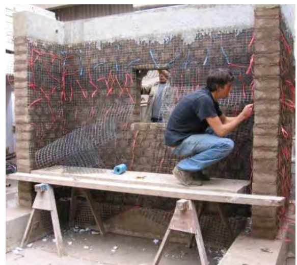
b) Colocación de la geomalla
