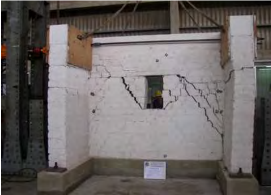
Figura 4.10. Muro sin refuerzo después del ensayo
