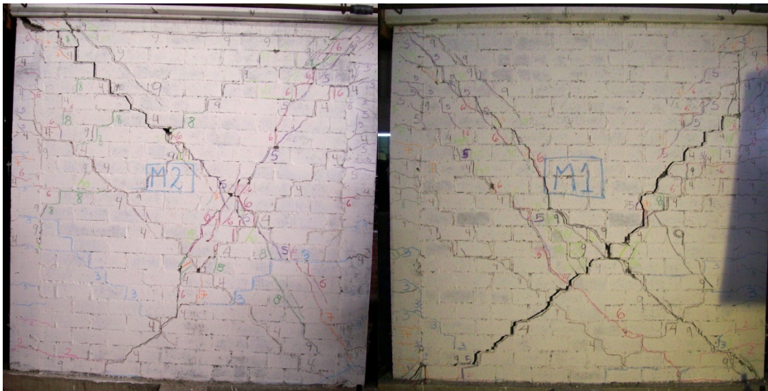
Fig.10.1.- Fisuras patrón para ambos muros
