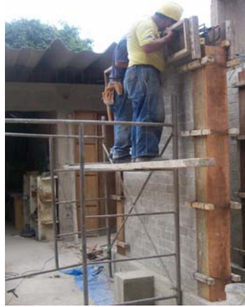
Fig.4.9.- Construcción de la viga solera
