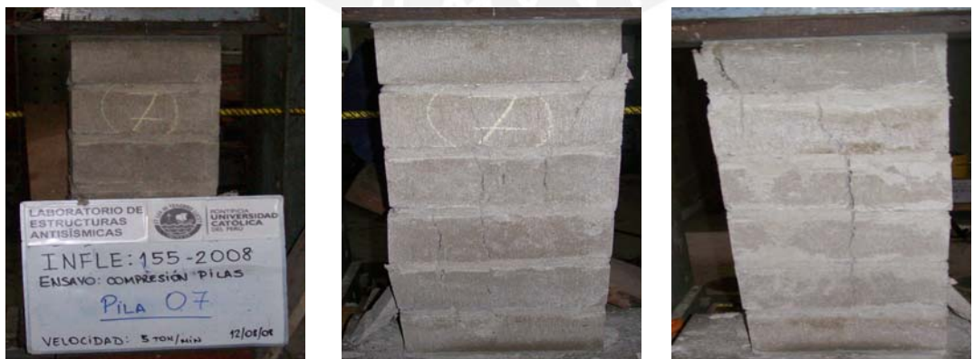
Fig. 3.13 - Falla de la Pila 07
