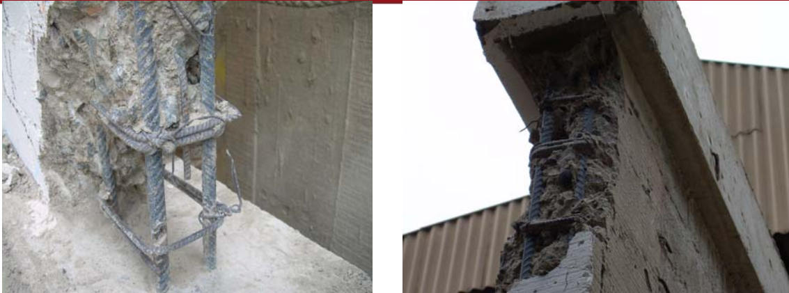
Fig.6.7.- Acero de refuerzo vertical
