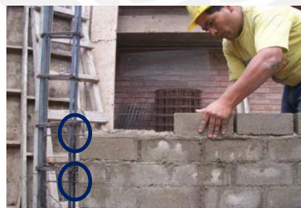
Fig.4.5.- Asentado de ladrillo (mechas cada 2 hiladas)
