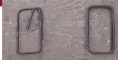
Fig. 4.3.- Estribos para refuerzo de vigas y columnas
