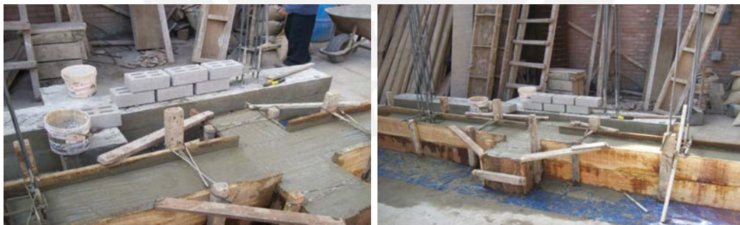
Fig. 4.4.- Encofrado y vaciado de la viga de cimentación
