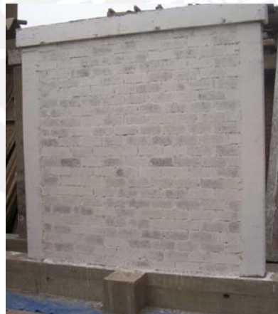
Fig. 4.10.- Muro de albañilería listo para ensayar
