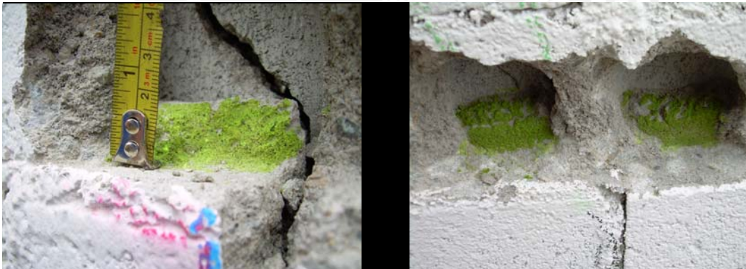
Fig.6.8.- Mortero dentro de los huecos de los ladrillos
