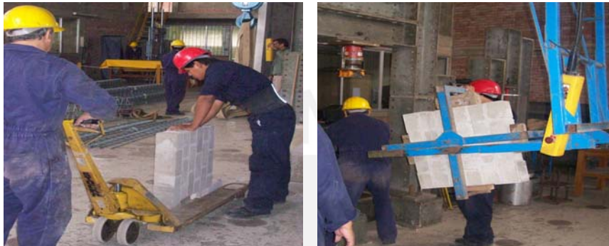
Fig. 3.17 – Traslado de muretes de ladrillos de concreto.
