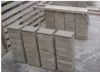
Fig. 3.2 - Colocación de capping en pilas de ladrillos de concreto
