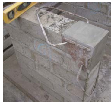
Fig. 3.16 - Colocación de capping en muretes de ladrillos de concreto
