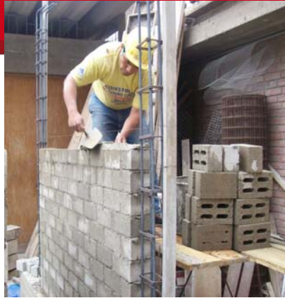
Fig.4.6.- Nivelación y plomo del muro
