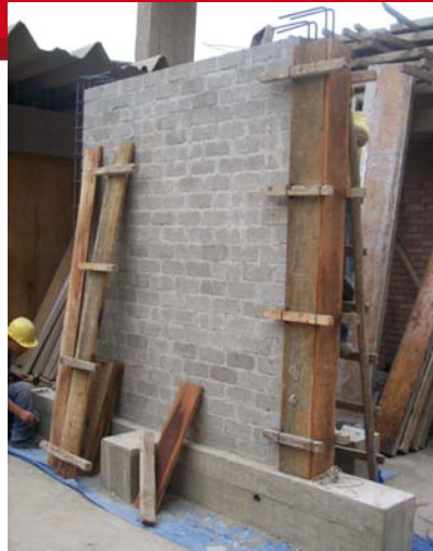
Fig.4.8.- Encofrado de columnas
