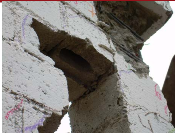
Fig.6.9.- Chicote de refuerzo entre albañilería y columna de amarre
