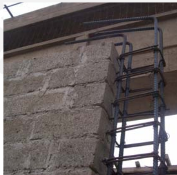
Fig.4.7.- Refuerzo de las columnas
